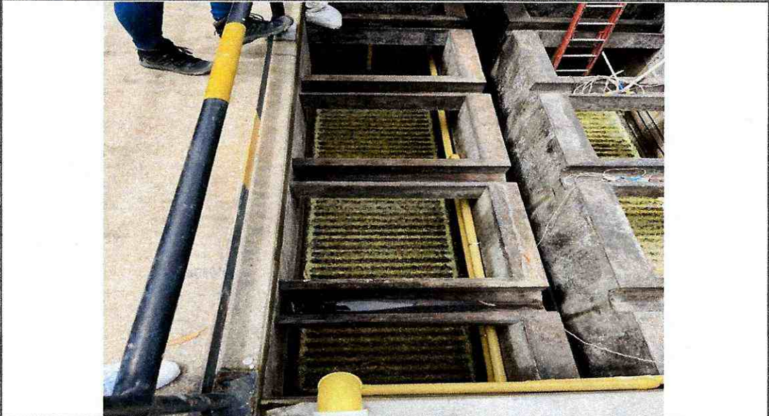
Se realiza la instalación de la malla difusora de aire en cada uno de los filtros intervenidos
