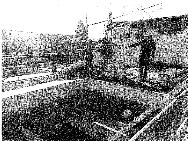
EXTRACCIÓN DEL MATERIAL DEL FILTRO
