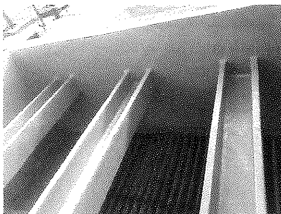
FILTRO CON VIGUETAS LIMPIAS Y REPARADAS Y CON LA PRIMERA CAPA DE GRAVA
