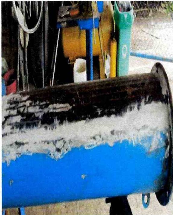
FIGURA 17. REPARACION ESTRUCTURAL TUBO EXTERNO CON ROLLER FRAME
