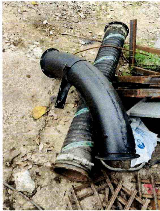
FIGURA 18. REPARACION ESTRUCTURAL CODO DE SUCCION CON SEAL FRAME
