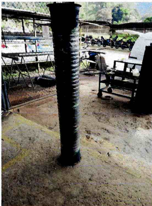
FIGURA 17. SUMINISTRO DE MANGUERA CON FLANCHE INSTALADOS
