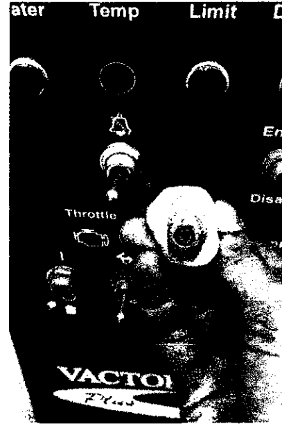
FIGURA 10. SUMINISTRO BOTON/SWITCH INSTALADO Y PUESTO EN FUNCIONAMIENTO
