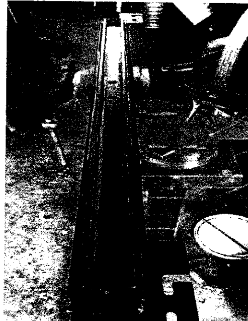
FIGURA 28. SUMINISTRO RIELES PARA CUBIERTA DE MOTOR AUXILIAR
