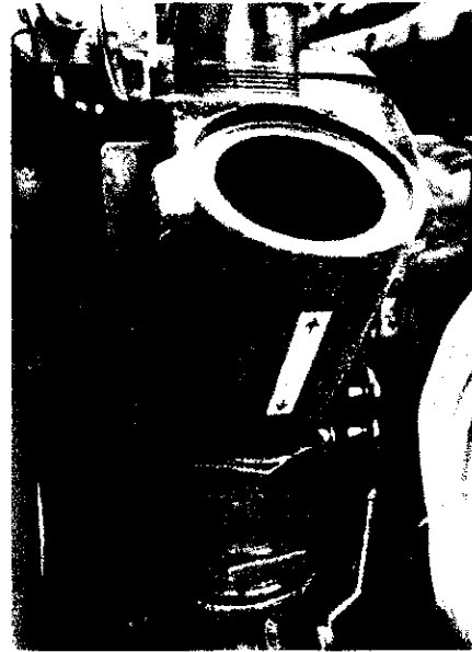
FIGURA 16. REVISIÓN Y MANTENIMIENTO EN CARCASA DE FILTRO SUPERIOR
