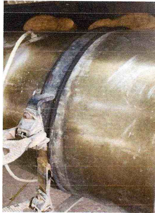
FIGURA 6. INSTALACION DE CAUCHO AISLANTE ENTRE CORREA Y TANQUE DE AGUA.
