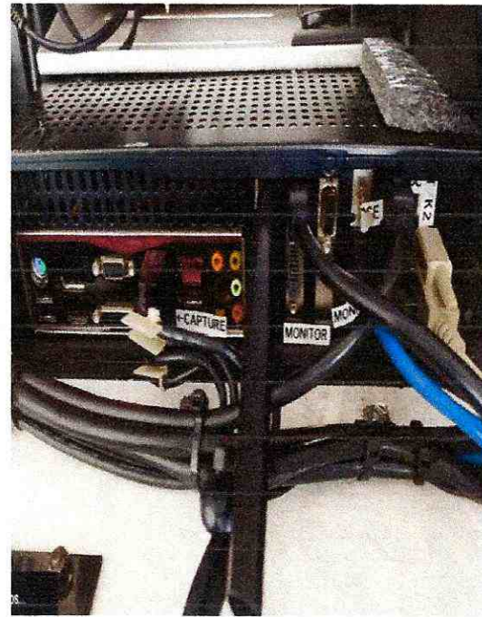
FIGURA 6. REVISION CABLEADO EQUIPO DE INSPECCION CCTV
