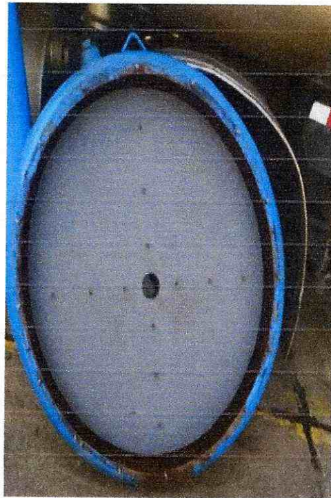
FIGURA 38. carcasa con espaciador, tornillos arandelas y tuercas nuevo
