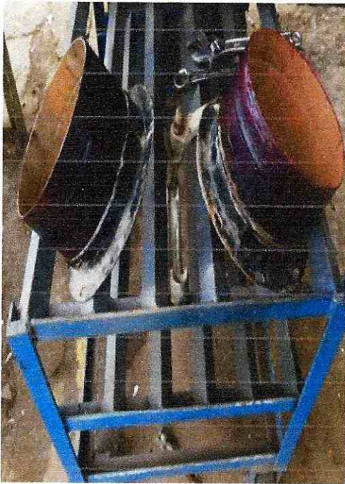
FIGURA 5. REEMPLAZO DE FLANCHES EN SISTEMA DE SUCCION.
