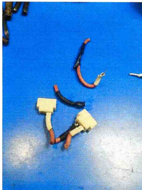
FIGURA 4. SULFATACION Y ROTURA PIN EN CONECTOR LUCES
