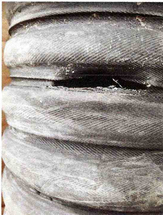
FIGURA 27. MANGUERA DE SUCCION EN MAL ESTADO
