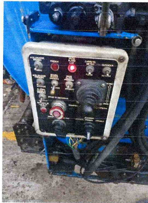
FIGURA 14. Cambio de switch arranque motor auxiliar
