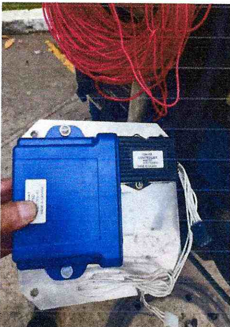
FIGURA 19. Instalación módulos de control nuevos
