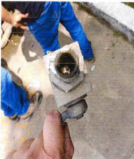
FIGURA 63. Revisión y desmontaje bomba de agua
