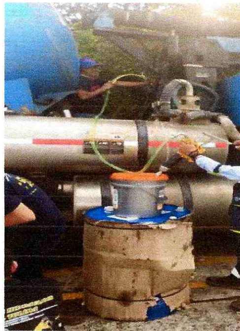
FIGURA 24. CAMBIO DE ACEITE HIDRAULICO
