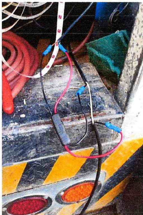
FIGURA 5. REEMPLAZO DE CONECTORES Y CABLE
