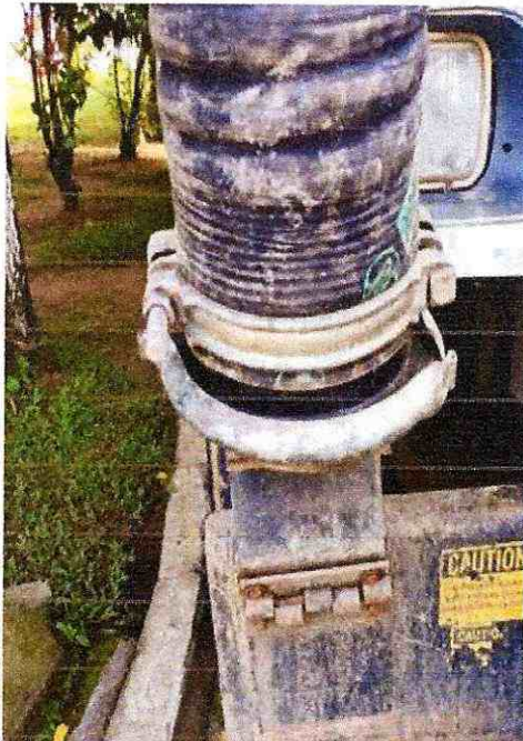
FIGURA 7. INSTALACION FLANCHES EN SISTEMA DE SUCCION.
