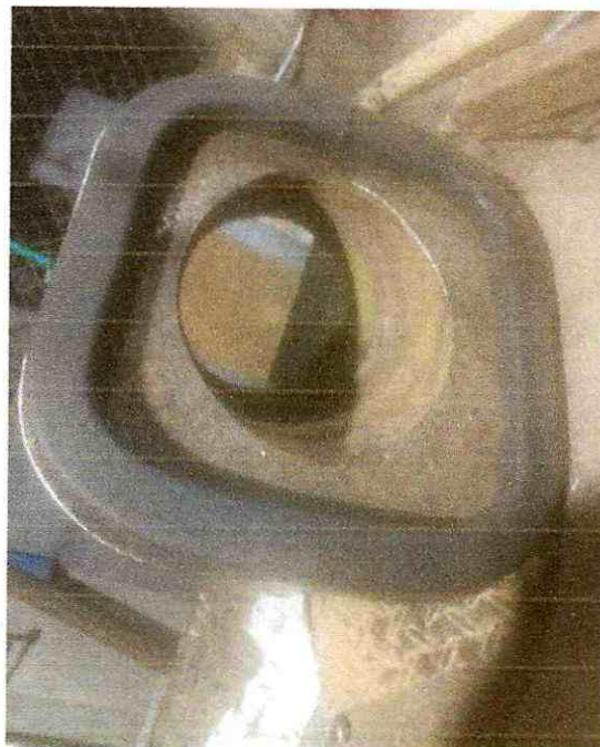
FIGURA 46. Montaje de sello en ducto de succión
