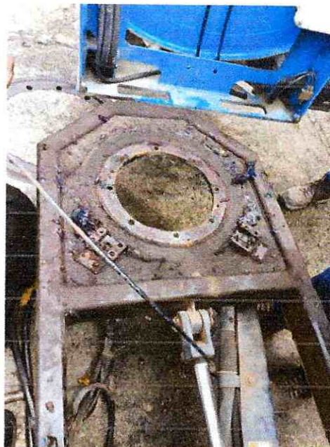
FIGURA 72. Desmontaje completo base carretel
