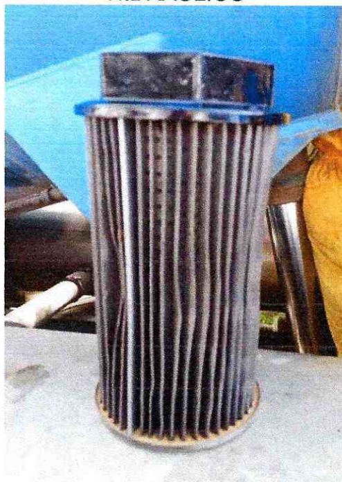
FIGURA 20. MANTENIMIENTO FILTRO INTERNO TANQUE ALMACENAMIENTO ACEITE HIDRAULICO
