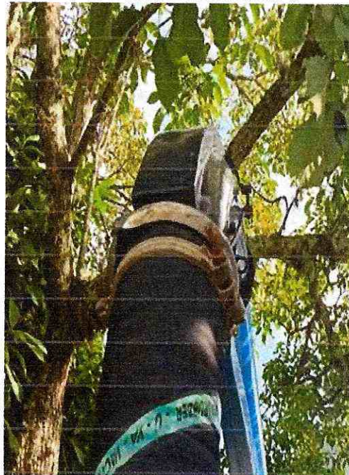
FIGURA 8. INSTALACION FLANCHES EN SISTEMA DE SUCCION
