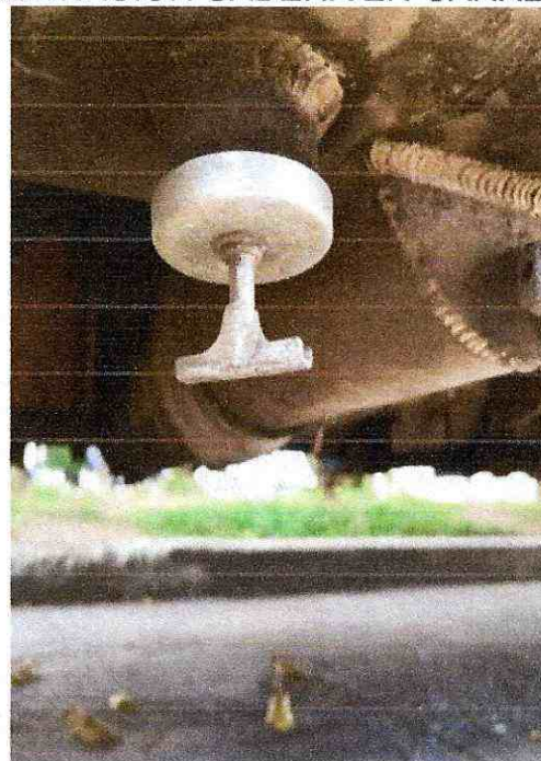
FIGURA 4. CAMBIO DE TAPON DE TANQUE
