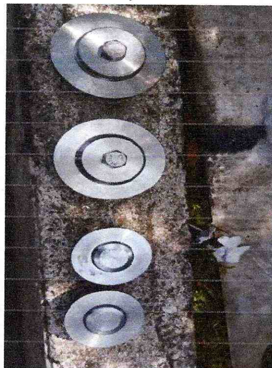
FIGURA 60. Válvula de retención de 2" y 3" nuevas
