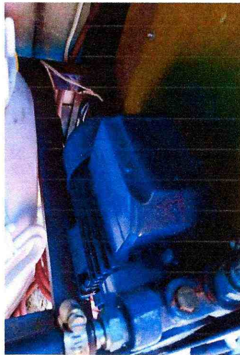
FIGURA 2. REVISIÓN EN BOMBA DE AGUA
