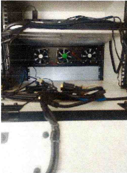
FIGURA 9. MANTENIMIENTO AJUSTE Y LIMPIEZA INTERIORES
