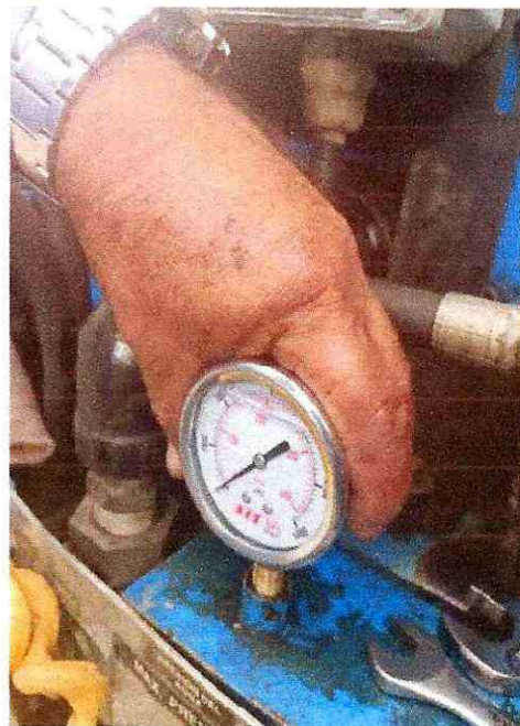
FIGURA 26. CAMBIO DE MANOMETRO DE PRESION
