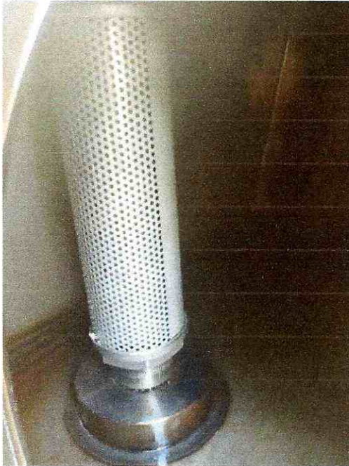
FIGURA 21. MANTENIMIENTO FILTRO INTERNO TANQUE ALMACENAMIENTO ACEITE HIDRAULICO
