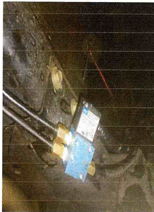
FIGURA 42. Reparación cableado y instalación válvula solenoide sistema alivio de succión
