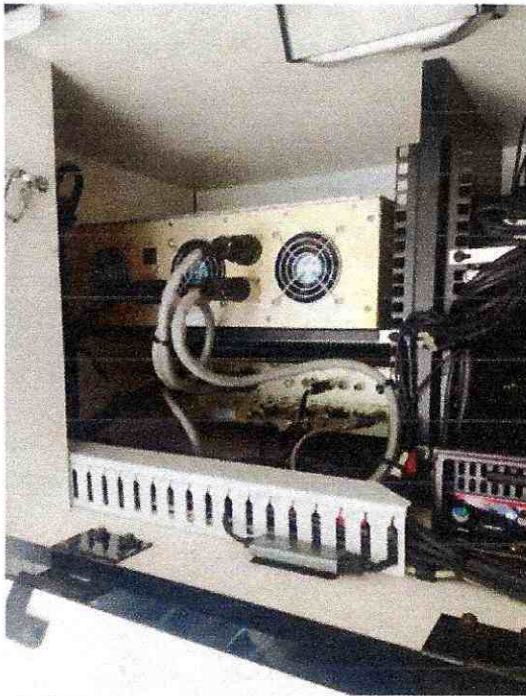
FIGURA 5. REVISION CABLEADO EQUIPO DE INSPECCION CCTV
