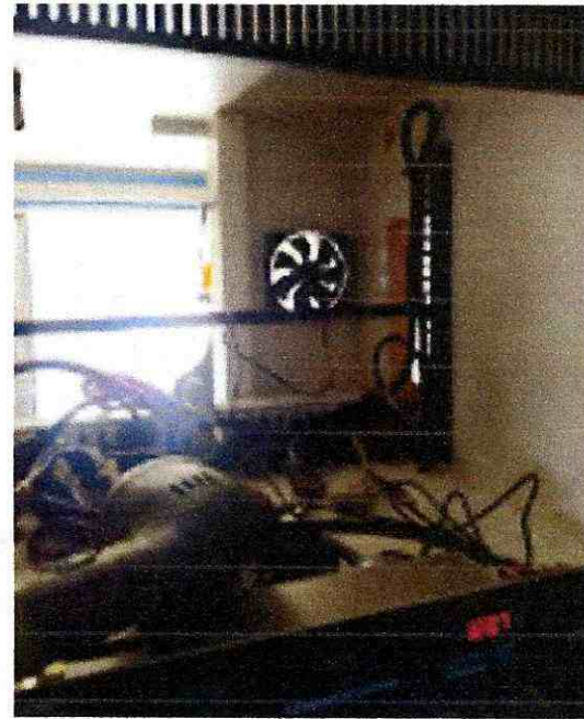
FIGURA 8. MANTENIMIENTO AJUSTE Y LIMPIEZA INTERIORES
