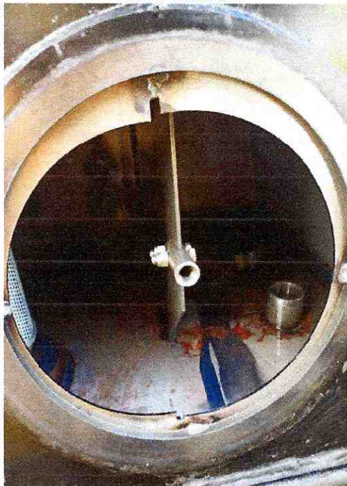
FIGURA 19. MANTENIMIENTO TANQUE ALMACENAMIENTO ACEITE HIDRAULICO
