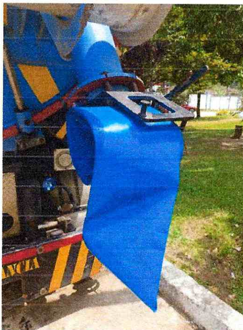
FIGURA 84. Montaje manguera drenaje nuevo
