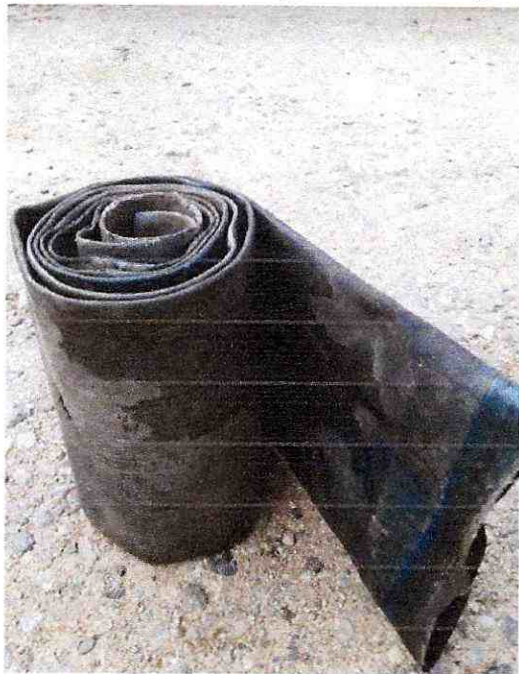
FIGURA 83. Manguera de drenaje con deterioro, genera fugas y contaminación
