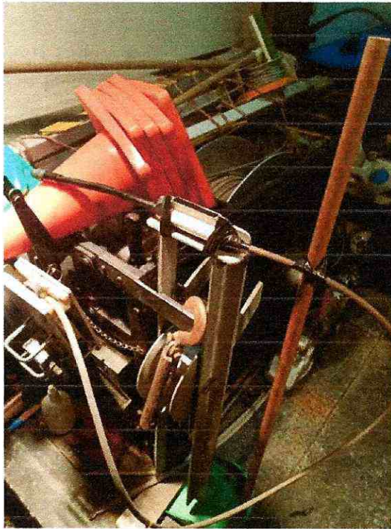
FIGURA 5. CAMBIO DE CONECTOR Y FUNDICION RESINA
