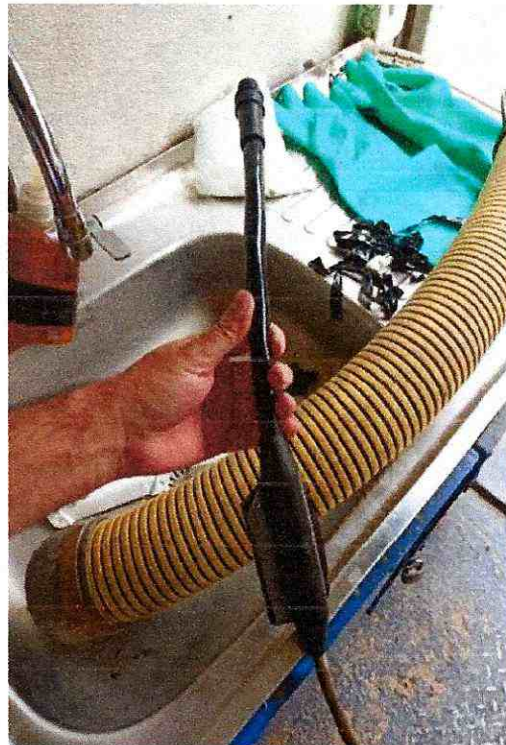
FIGURA 6. CAMBIO DE CONECTOR Y FUNDICION RESINA
