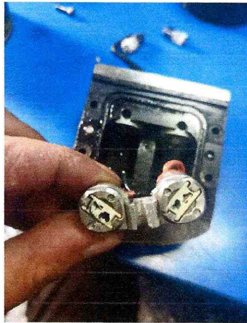
FIGURA 2. SULFATACION EN CONECTORES DE CAMARA
