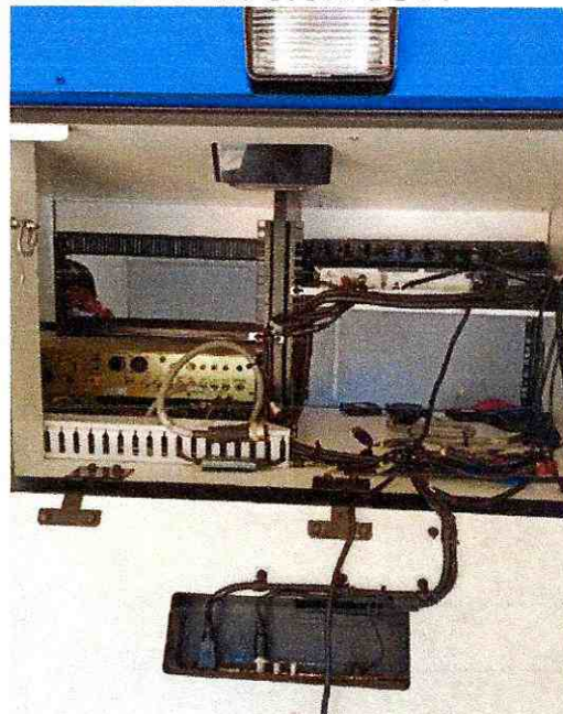
FIGURA 4. REVISIÓN CABLEADO EQUIPO DE INSPECCIÓN CCTV
