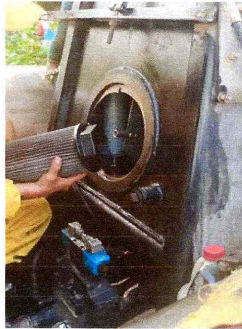
FIGURA 18. MANTENIMIENTO TANQUE ALMACENAMIENTO ACEITE HIDRAULICO
