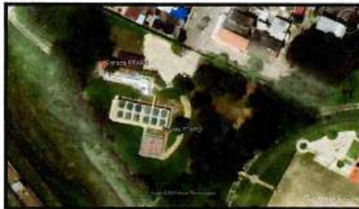
Foto 3. Entrada y Salida de la PTARD Comfenalco, en la ciudad de Ibagué. Fuente: Google Earth.
