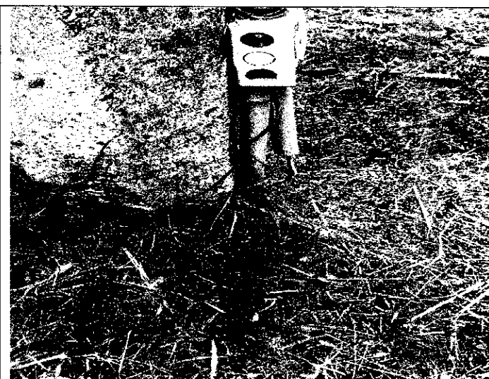
Reparación circuito eléctrico por corete de guadaña en piedra pintada
