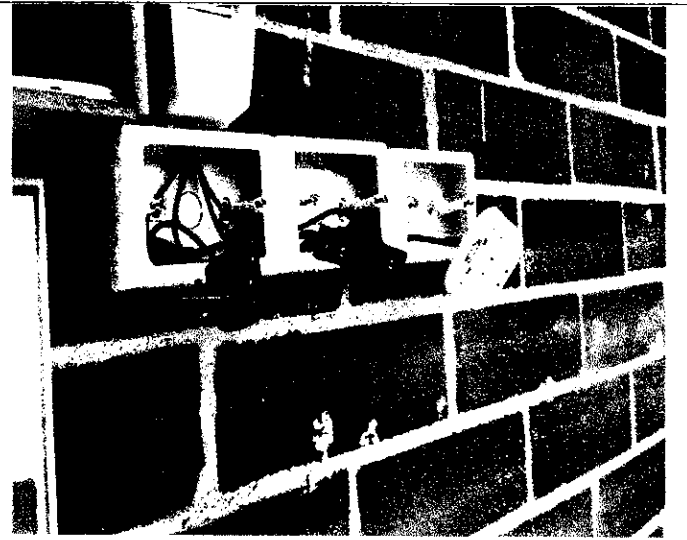
Instalación de salidas a 220 v ptar Comfenalco
