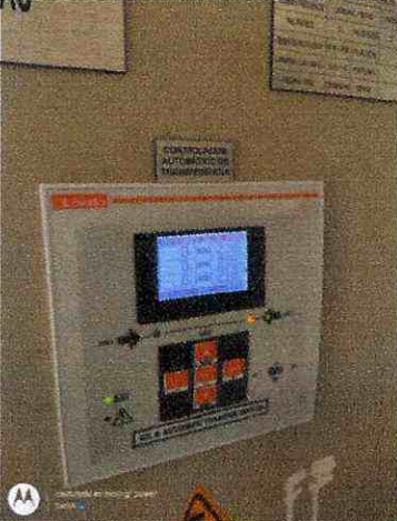
Mantenimiento planta combeima
