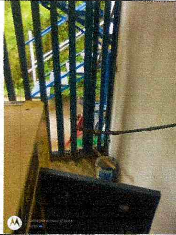
Mantenimiento planta combeima
