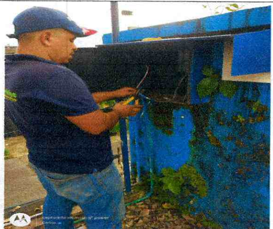
Reparación cerca interlaken
