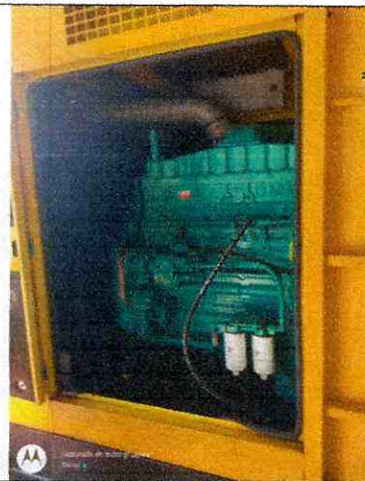
Mantenimiento planta la pola
