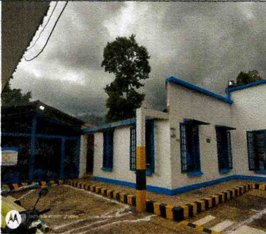
Cambio reflectores patio de gerencia
