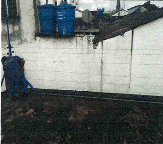
Reparación cerca interlaken
