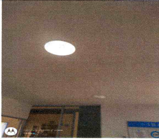
Cambio de panel led de 24 w panta 1
