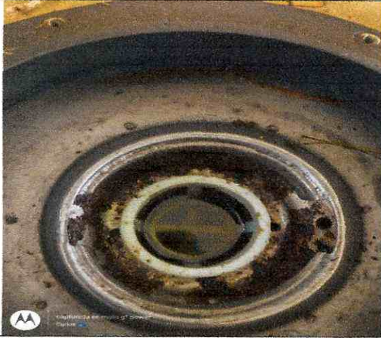
Mantenimiento planta electrica combeima
