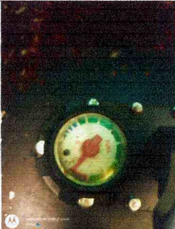
Mantenimiento planta la pola
