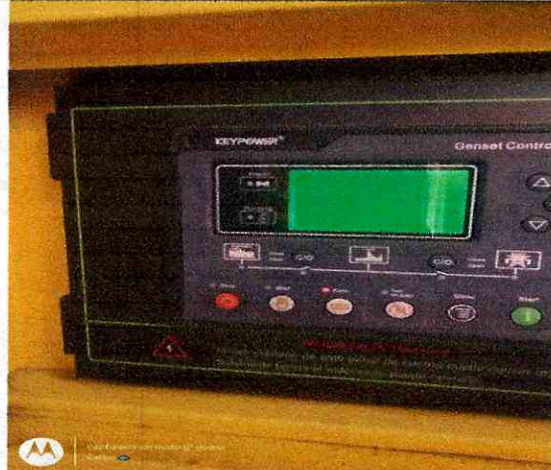
Mantenimiento planta electrica combeima
