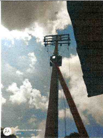
Cambio de reflectores tanque ambala
