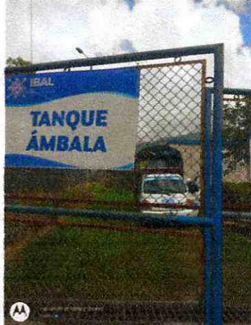
Cambio de reflectores tanque ambala
