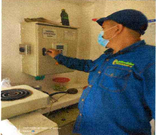
Mantenimiento planta electrica combeima
