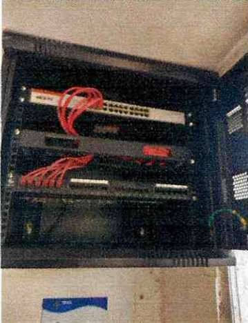
Instalación de racks cadiz
