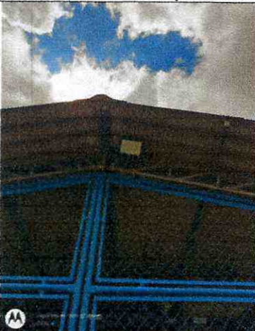
Reparación de reflectores patio de gerencia y almacen
