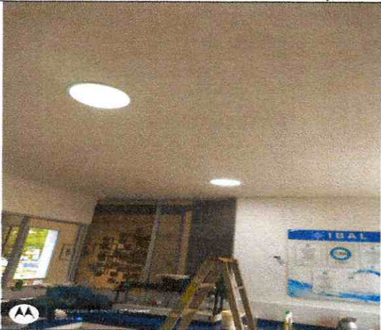
Cambio de panel led de 24 w panta 1
