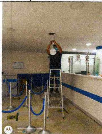
Cambio de luminarias pas la 15
