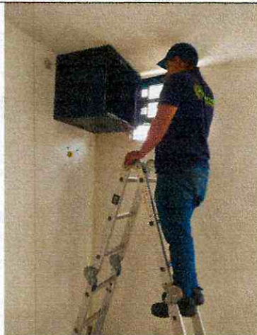
Instalación de racks cadiz
