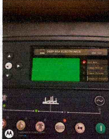
Mantenimiento planta la pola
