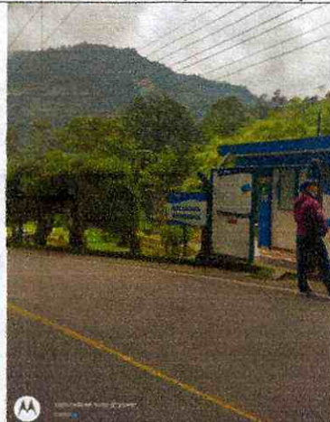
Mantenimiento planta combeima
