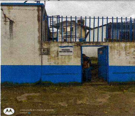
Reparación cerca interlaken
