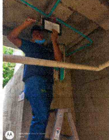
Cambio de reflectores planta el tejar
