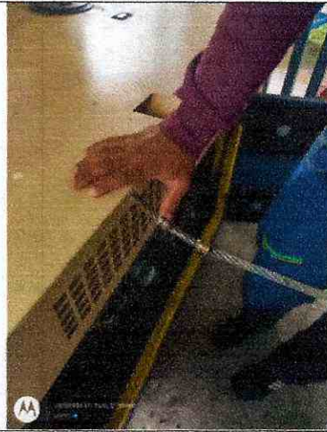
Mantenimiento planta combeima
