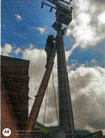
Cambio de reflectores tanque ambala
