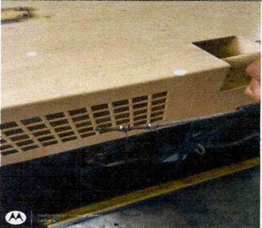
Mantenimiento planta electrica combeima
