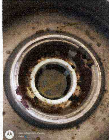
Mantenimiento planta combeima
