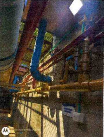
Cambio de reflectores planta el tejaz
