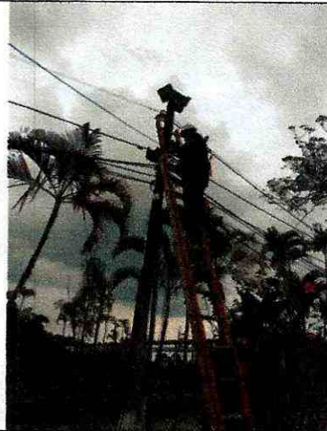
Cambio de cable de red control perdidas
