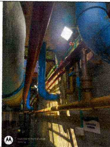
Cambio de reflectores planta el tejaz
