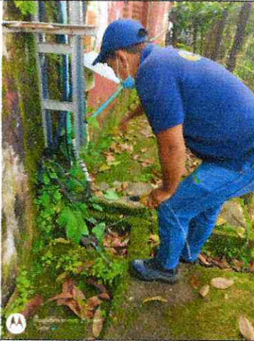
Reparación daño talleres
