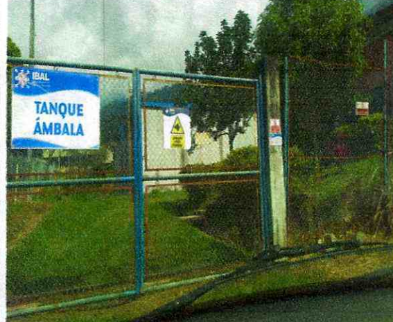
Revisión daño tanque ambala
