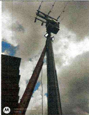
Cambio de reflectores tanque ambala
