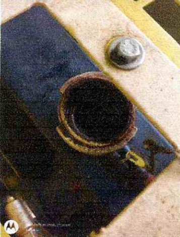
Mantenimiento planta combeima
