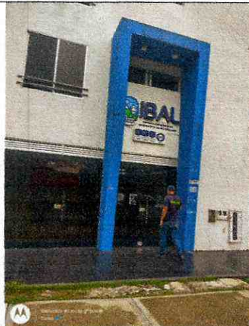
Instalación de racks cadiz
