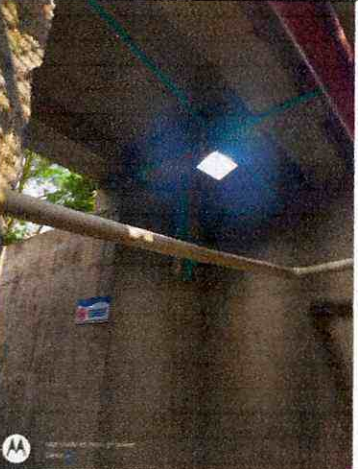
Cambio de reflectores planta el tejaz
