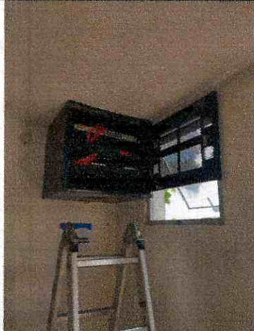
Instalación de racks cadiz
