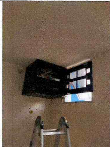
Instalación de racks cadiz
