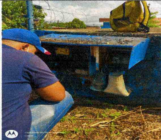
Desmontaje generador de pulso
