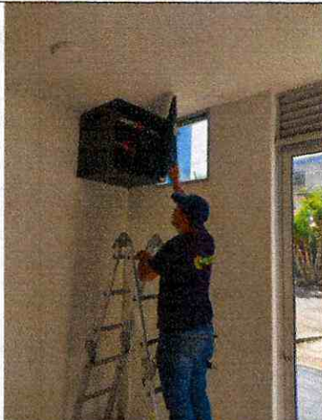
Instalación de racks cadiz
