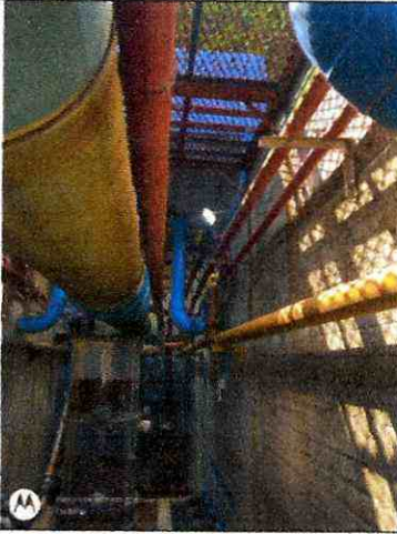
Cambio de reflectores planta el tejaz
