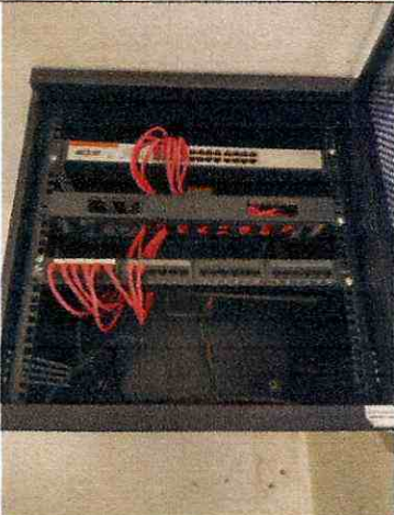
Instalación de racks cadiz
