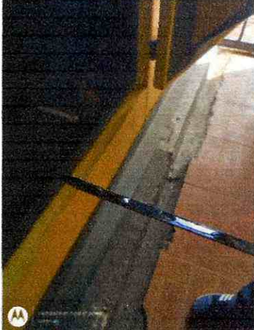
Mantenimiento planta la pola
