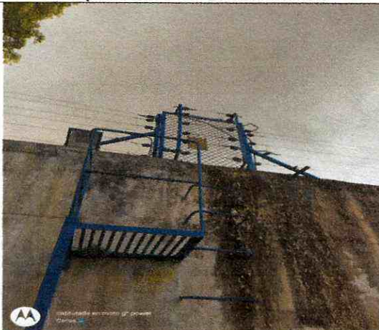
Instalación reflector tanque interlaken
