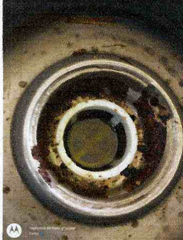
Mantenimiento planta combeima
