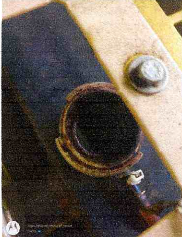
Mantenimiento planta combeima
