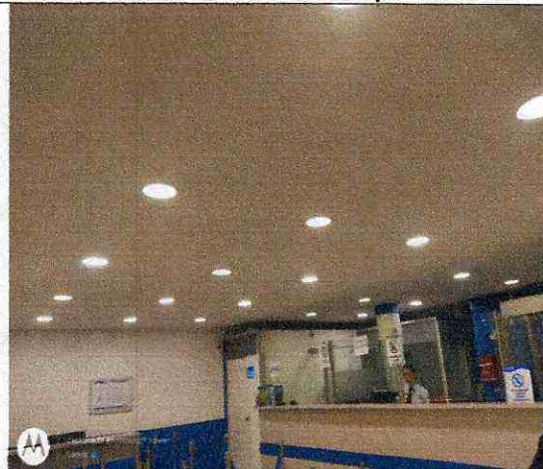
Cambio de luminarias pas la 15
