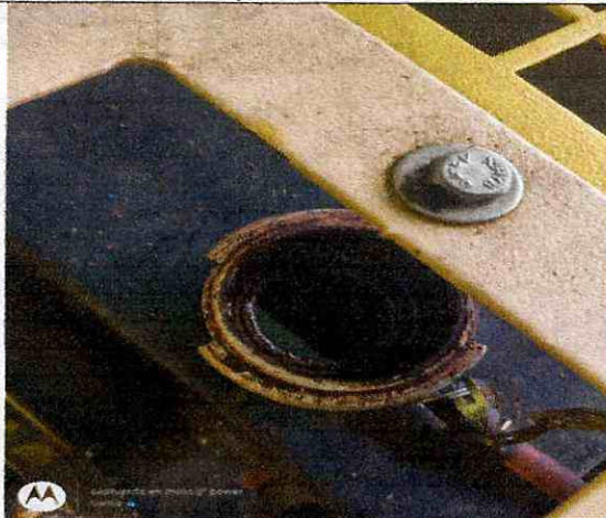
Mantenimiento planta electrica combeima
