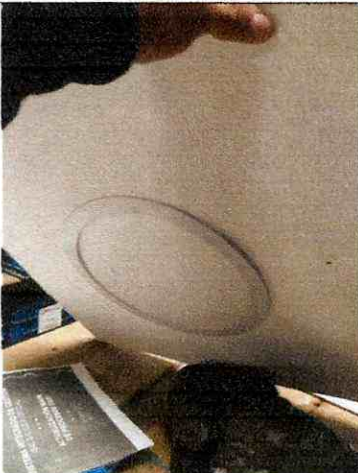
Cambio de luminarias almacen
