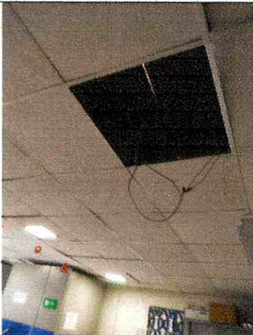
Cambio de luminarias almacen
