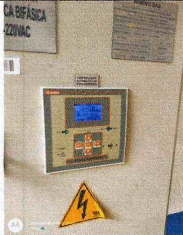
Mantenimiento planta combeima
