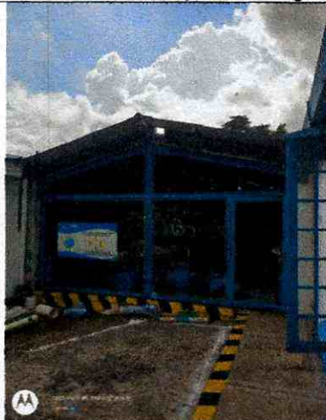
Cambio reflectores patio de gerencia
