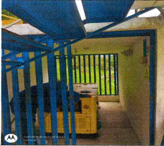
Mantenimiento planta electrica combeima
