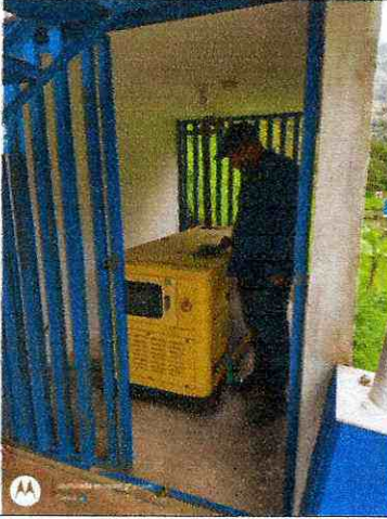
Mantenimiento planta combeima
