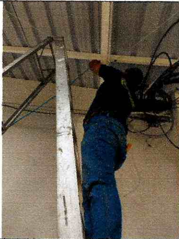
Cambio de cable de red control perdidas
