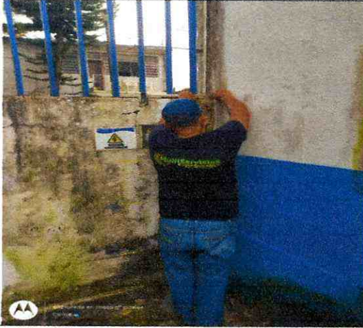
Reparación cerca interlaken
