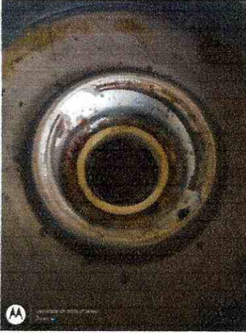
Mantenimiento planta combeima
