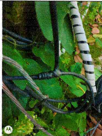
Reparación daño talleres
