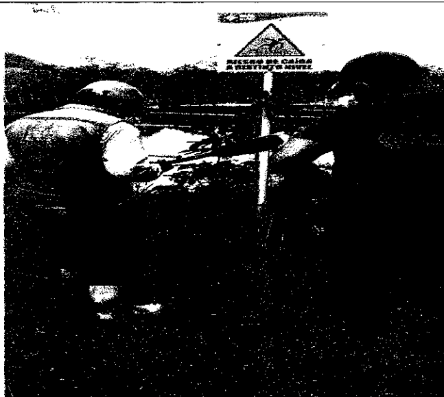
Apertura de perforaciones para los postes de la ptar el tejat
