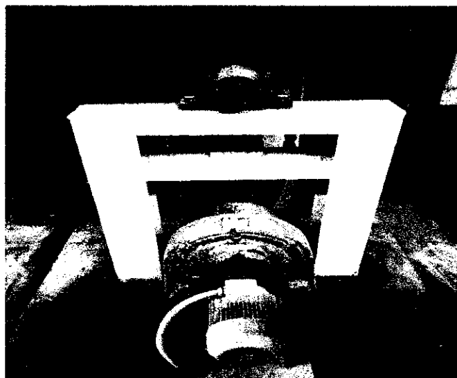
Figura 5. Floculador Horizontal 1 Modulo 1 PTAP 1.
