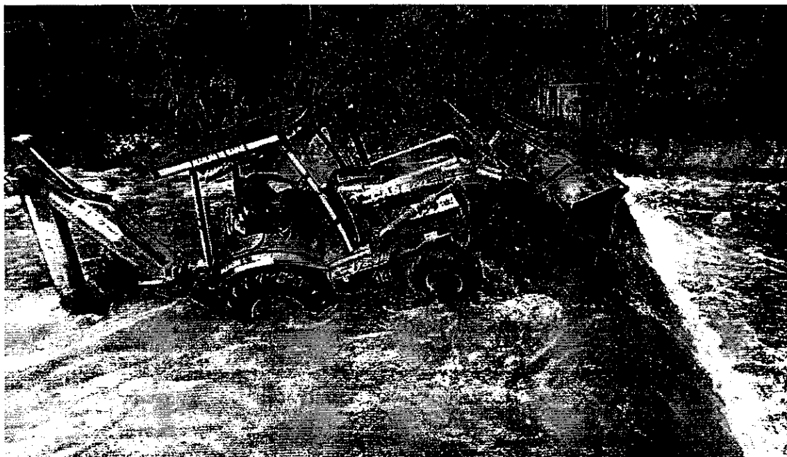
Figura 3. Retroexcavadora removiendo material de arrastre Bocatoma Cay.
