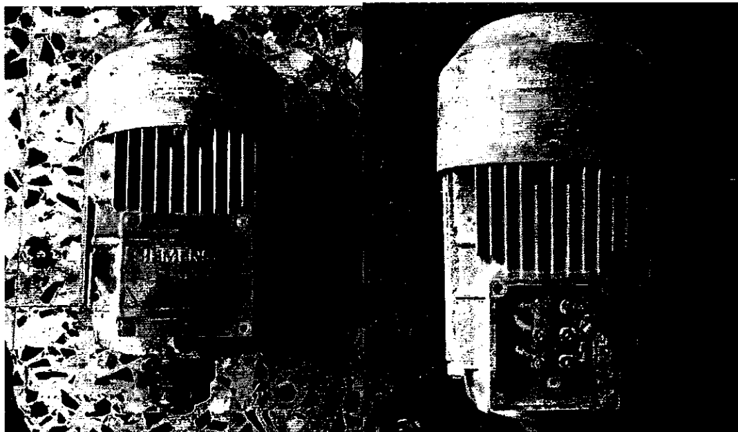
Figura 7. Motor siemens de unidades motrices floculación horizontal.
