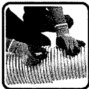
Paso 1 Marque la profundidad de la campana
