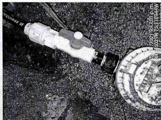
SUMINISTRO E INSTALACIÓN DE REGISTRO DE INCORPORACIÓN, UNIÓN PF, LLAVE DE PASO, TUBERIA POLIETILENO Y COLLAR DE DERIVACION DE 1/2"
