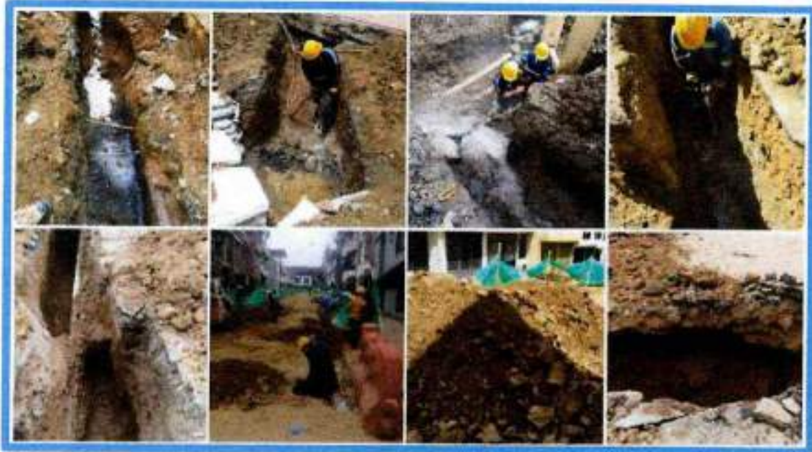
6,15 ROTURA PAVIMENTO FLEXIBLE (INCLUYE CARGUE A MANO Y RETIRO DE SOBRANTES)
