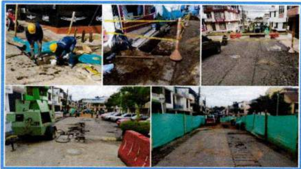
6,15 ROTURA PAVIMENTO FLEXIBLE (INCLUYE CARGUE A MANO Y RETIRO DE SOBRANTES)
