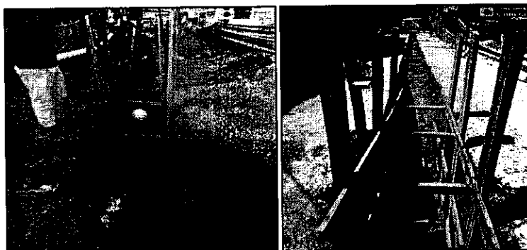
Ilustración 28. Entibado en Madera.
