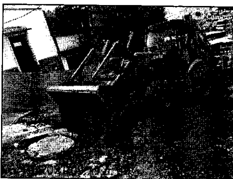
Ilustración 8. Lleno y Compactación Zanjas de Acometidas Acueducto.
