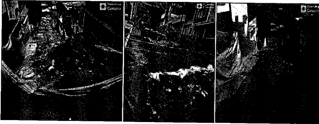
Ilustración 14. Cerramiento en Lona.
