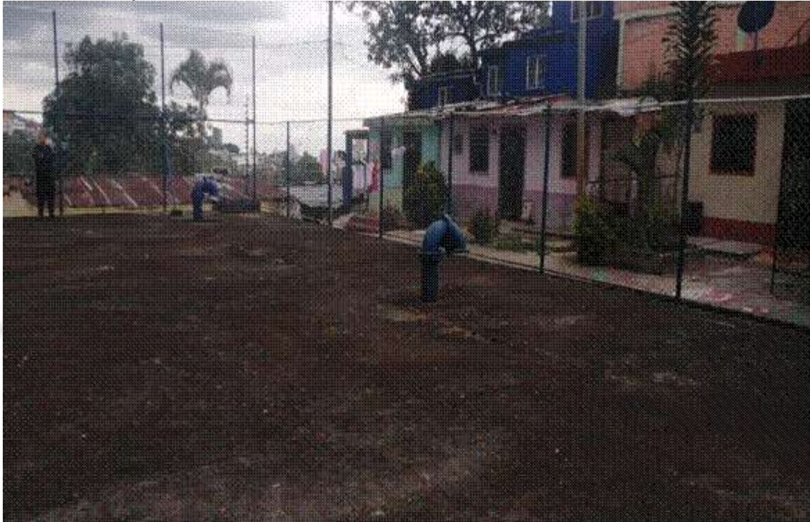
Cerramiento perimetral oriente.
