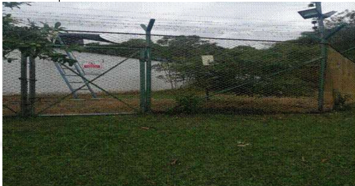
Cerramiento perimetral oriente.
