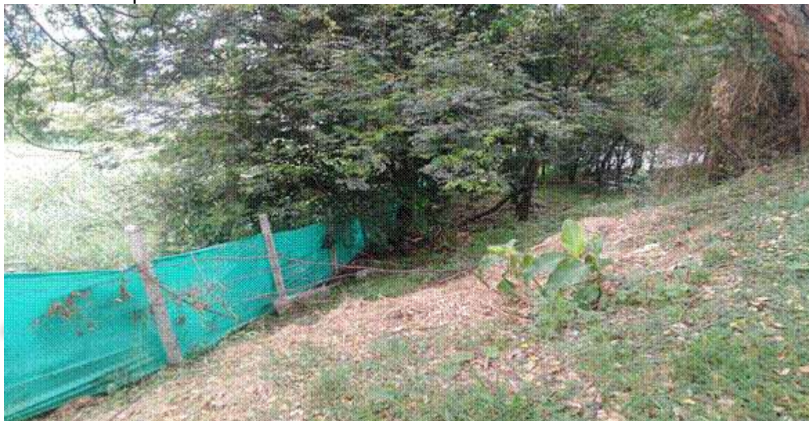
Cerramiento perimetral costado norte.
