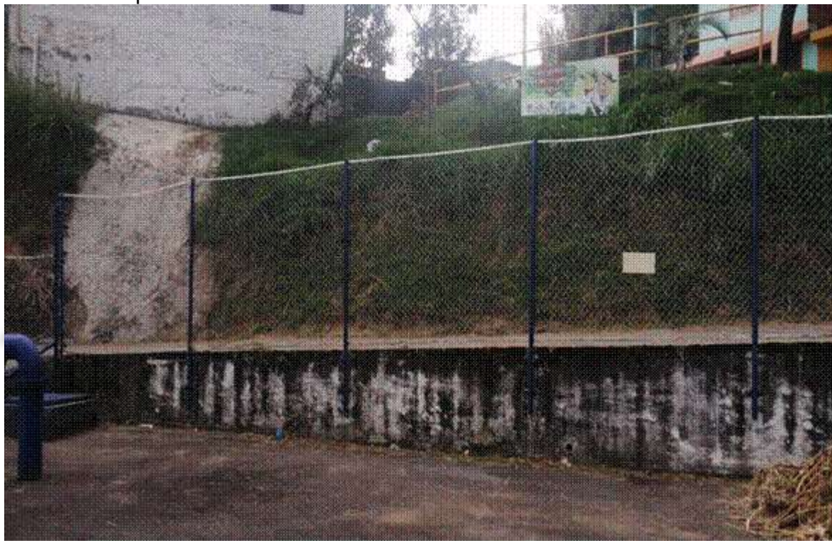
Cerramiento perimetral costado norte.
