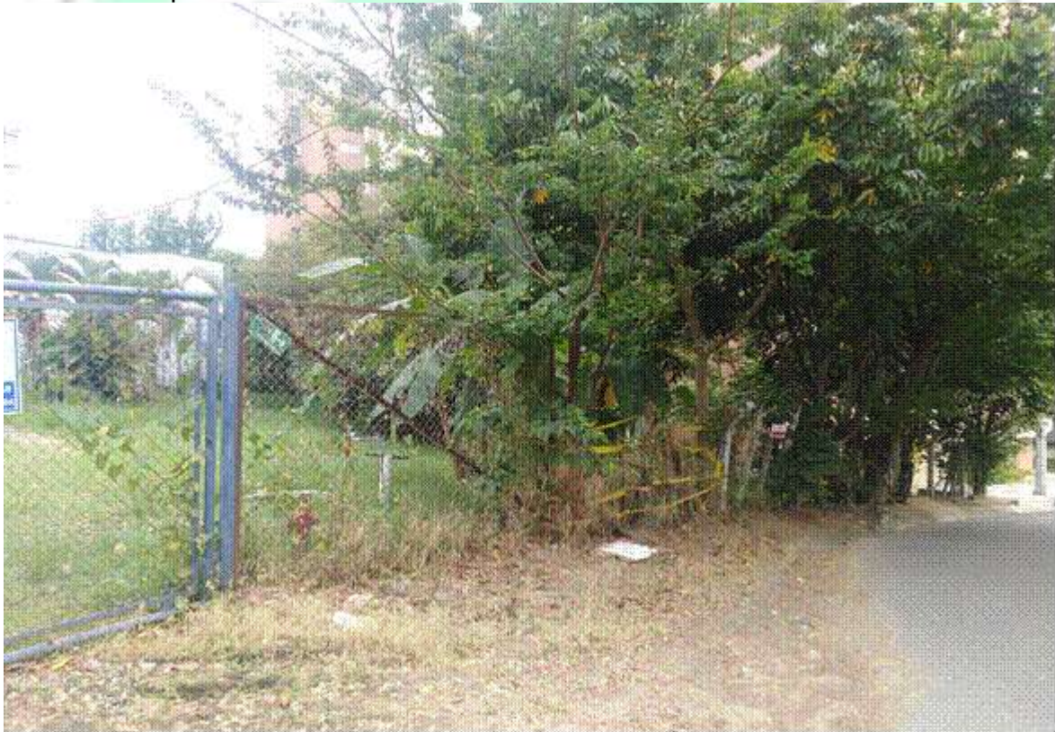
Cerramiento perimetral costado occidente
