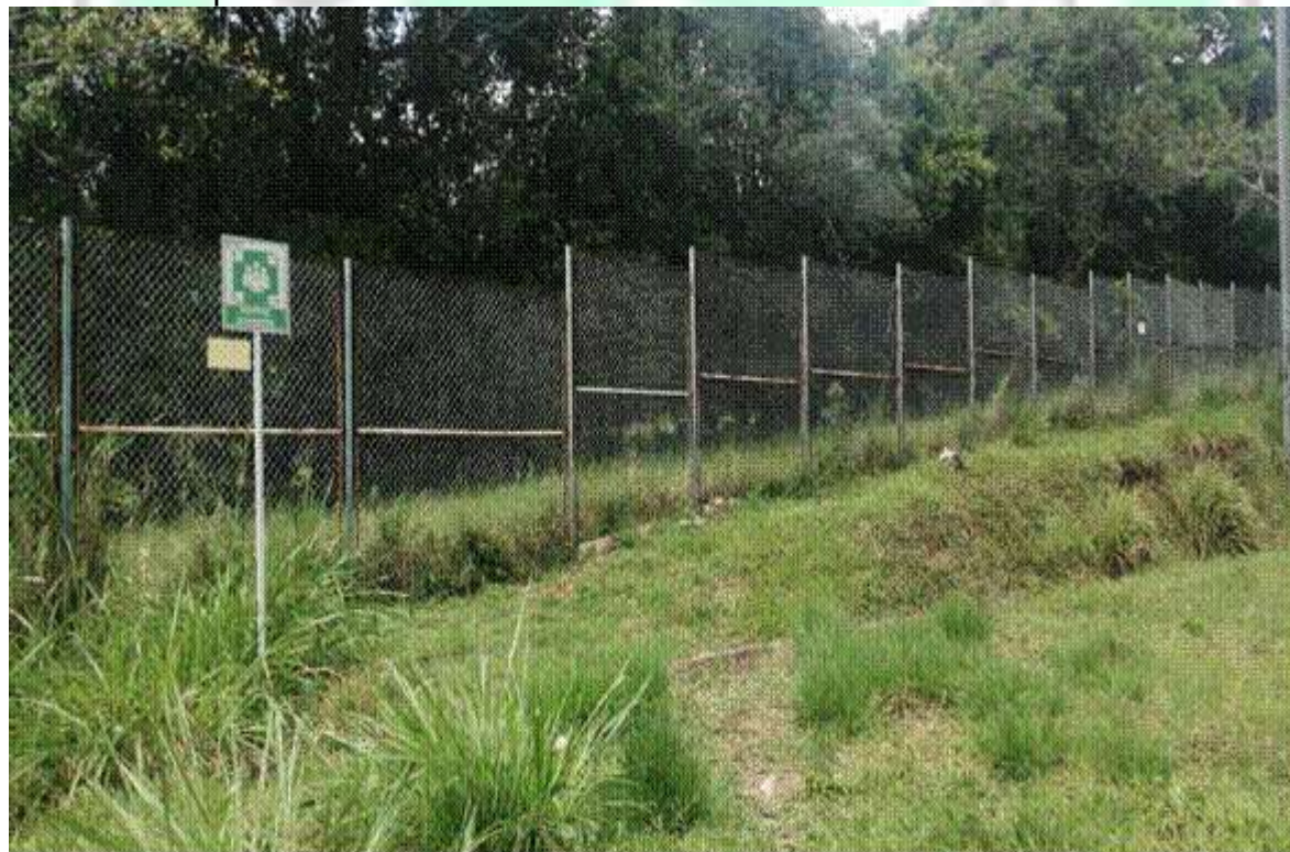
Cerramiento perimetral oriente.
