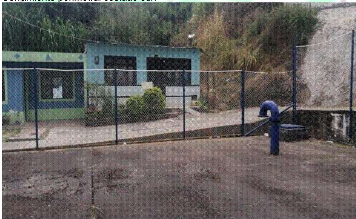
Cerramiento perimetral costado sur.
