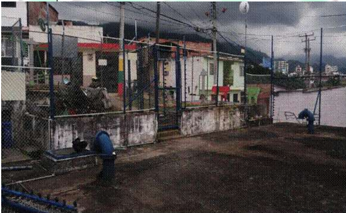
Cerramiento perimetral costado occidente
