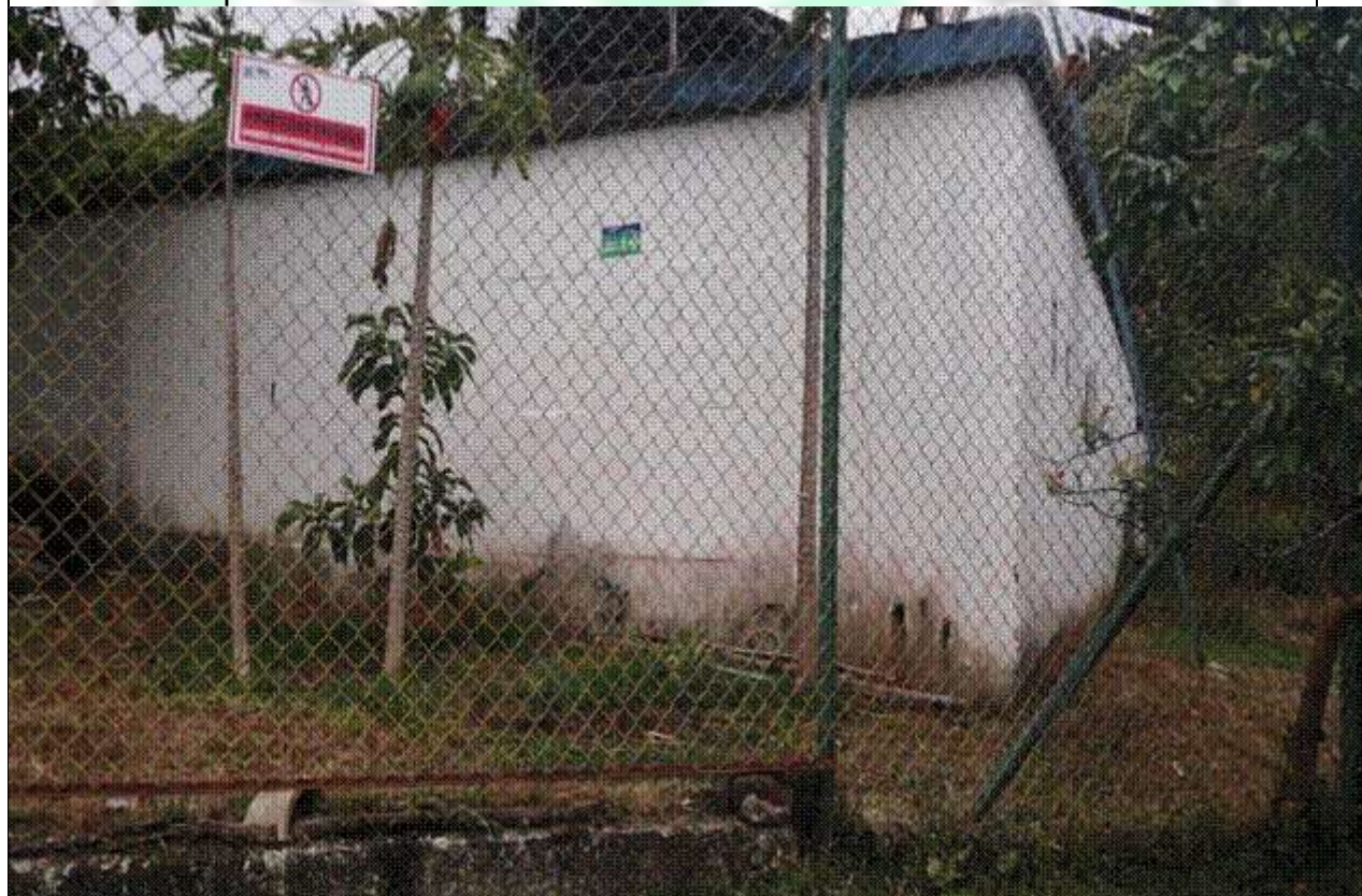
Cerramiento perimetral costado occidente
