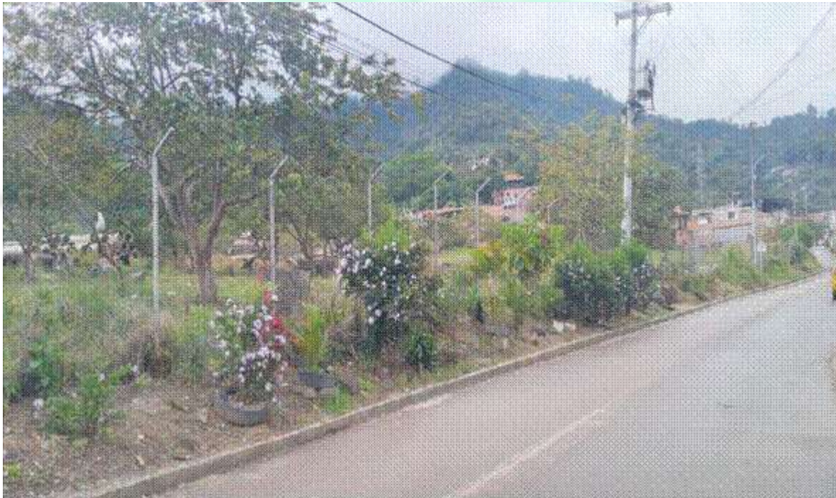
Cerramiento perimetral oriente.
