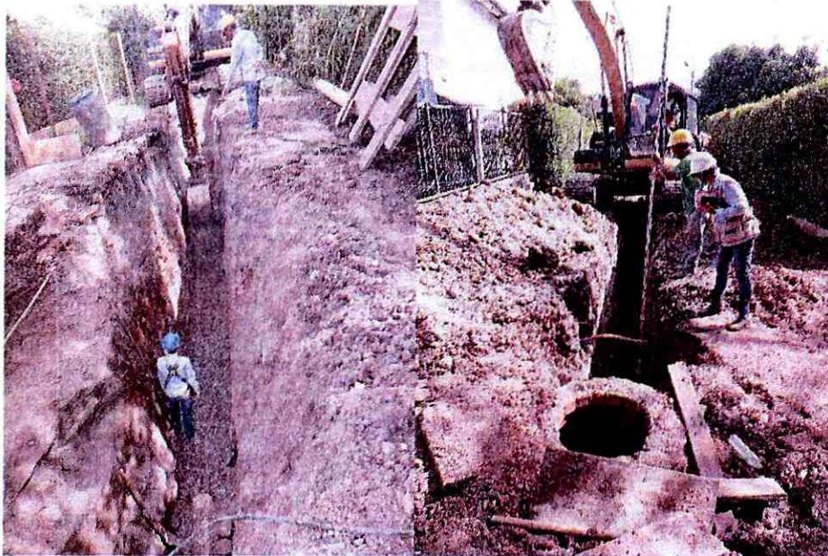
Excavación mecánica de 2.00 a 4.00 metros de profundidad
