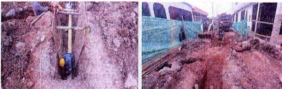
Instalación de tubería red principal de alcantarillado, lleno y compactación de recebo red principal de alcantarillado.
