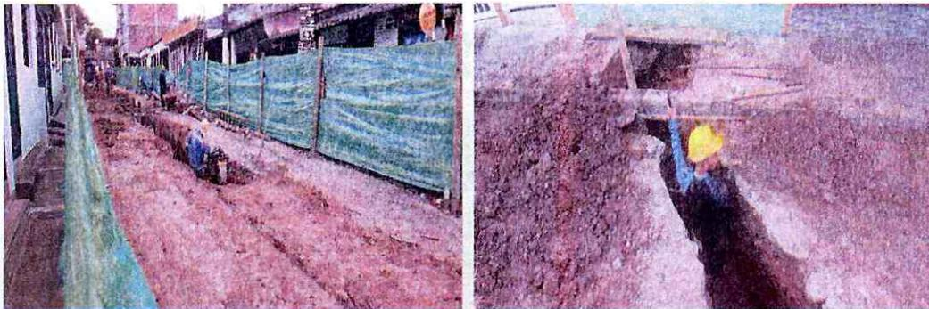
Lleno y compactación de rebase red principal de alcantarillado, corte y excavación de acometidas y cajas aguas negras.
