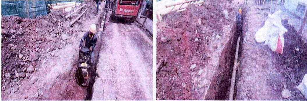
Lleno y compactación de recebo red principal de alcantarillado, instalación de tubería red principal de alcantarillado.
