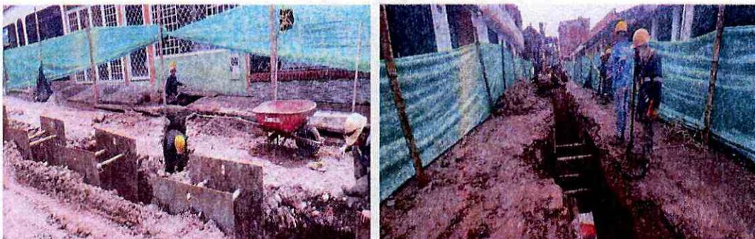
Instalación de entibado en red principal de alcantarillado, excavación para tubería red principal de alcantarillado.
