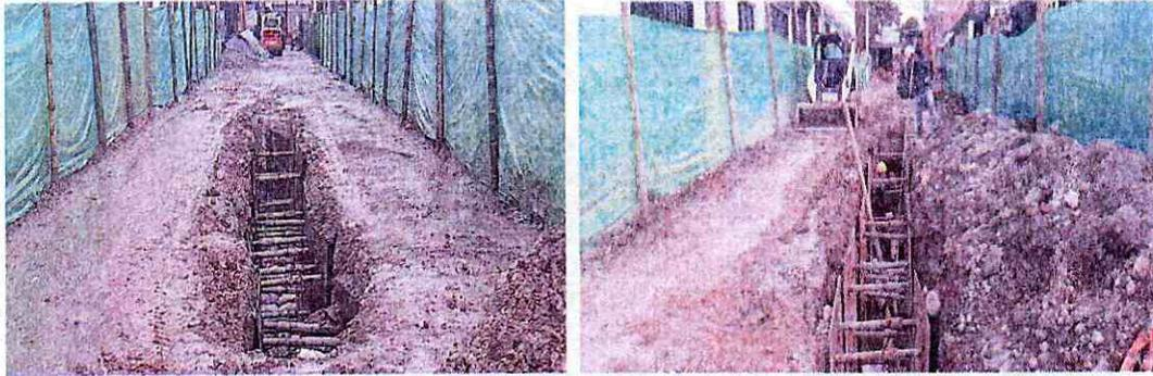
**Excavación para tubería red principal de alcantarillado, instalación de entibado en excavación red principal de alcantarillado.**
