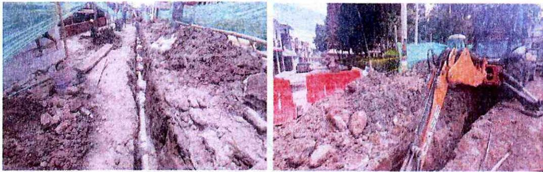
Instalación de tubería red principal de alcantarillado, excavación para tubería red principal de alcantarillado.
