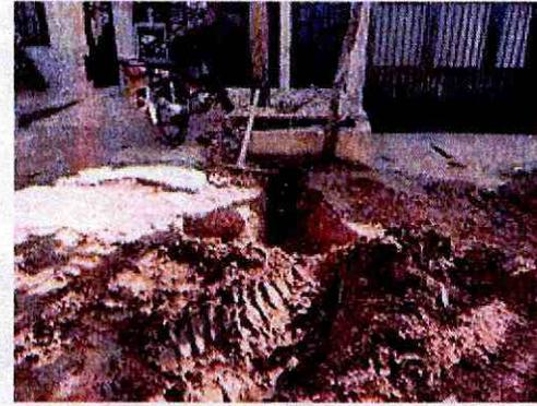
**Observación:** En excavación de acometida para el colegio de identifica fuga de agua en anden, se ejecutan actividades de reparación para tubería de ½
