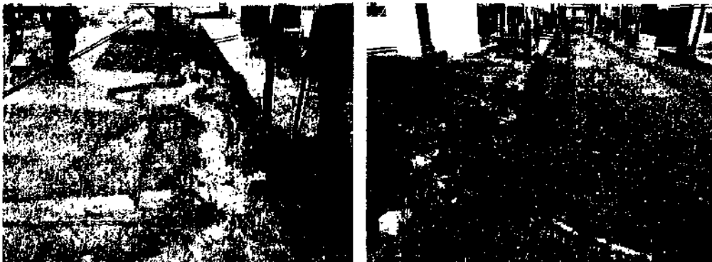
Trazado y corte de zanja de alcantarillado
