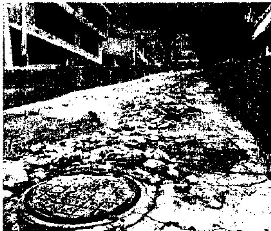
ROTURA DE PAVIMENTO RIGIDO
