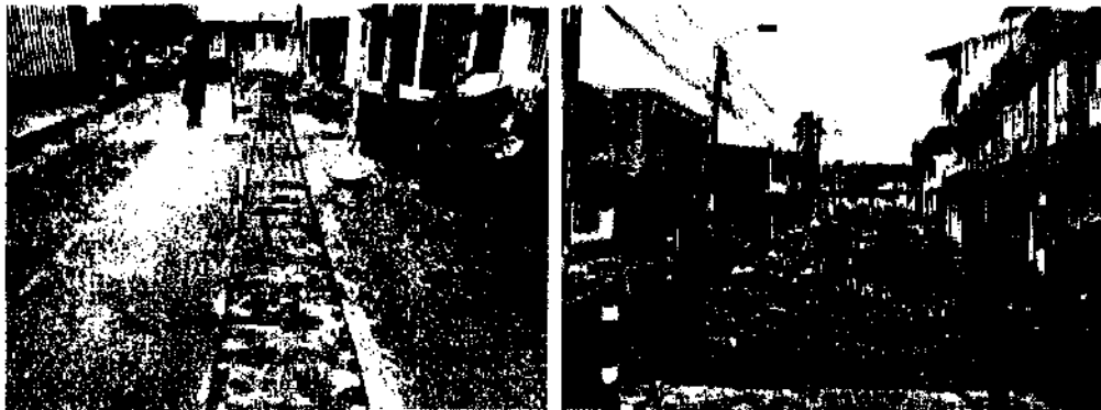
Trazado y corte de zanja de alcantarillado
