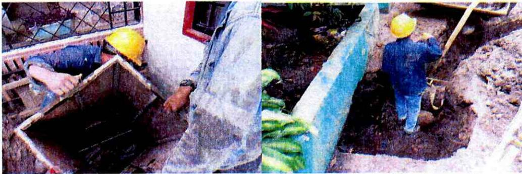
**Excavación para cajas de inspección alcantarillado.**
