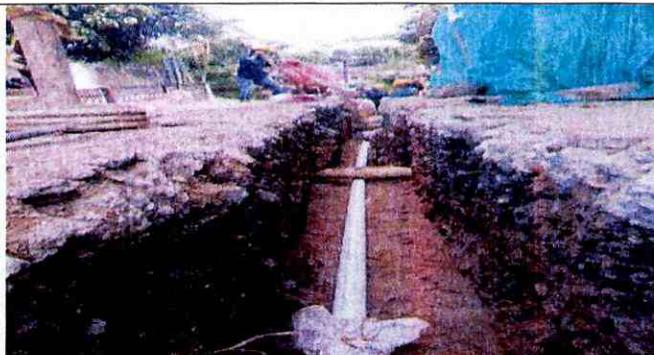
**Excavación e instalación de tubería red principal de acueducto.**
