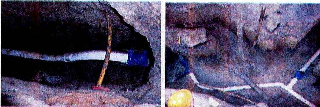
Instalación de tubería y accesorios para empalme acueducto.
