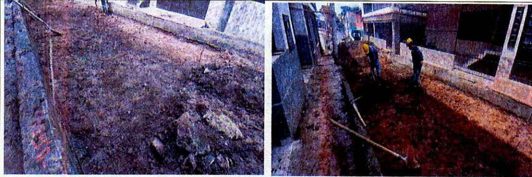
**Corte y excavación para cajeo de vía.**
