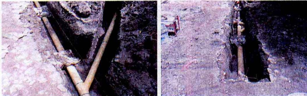
**Instalación de tubería red principal y acometidas alcantarillado.**
