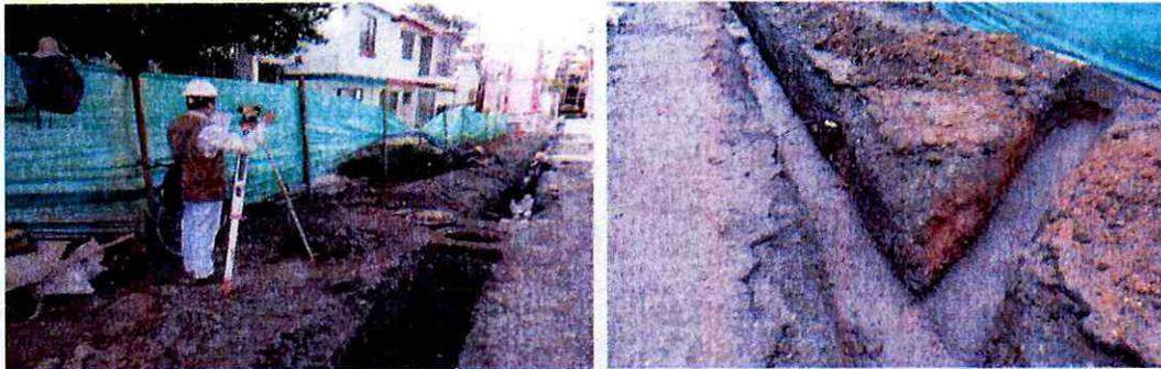
**Chequeo de nivel de tubería, recubrimiento en concreto de tubería red principal y acometidas alcantarillado.**
