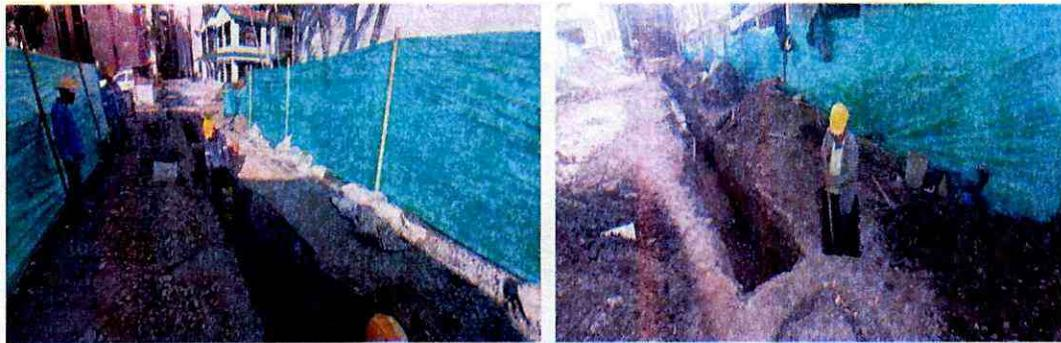
Lleno y compactación con rebase de excavaciones de tubería red principal y acometidas alcantarillado.
