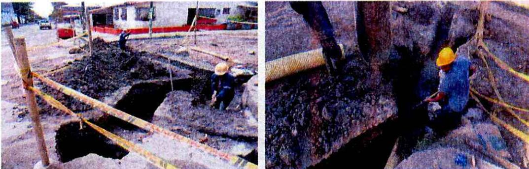
Excavación para empalme acueducto, instalación y recubrimiento de tubería sumideros aguas lluvias.
