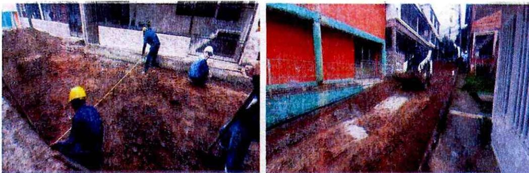
Corte y excavación para cajeo de vía.
