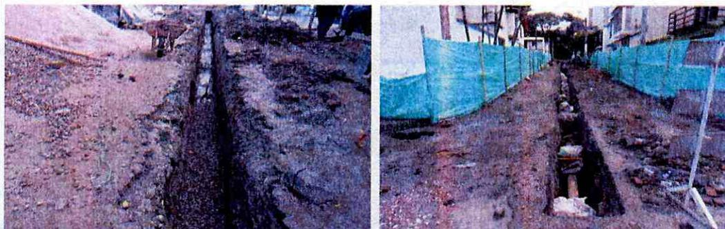
**Corte y excavación para red principal de alcantarillado, Instalación tubería red principal de alcantarillado.**
