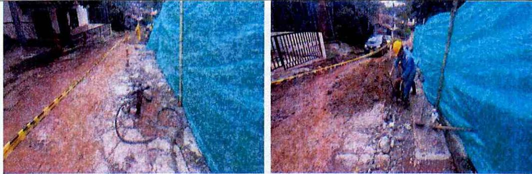
Corte y demolición para tubería red principal de acueducto.
