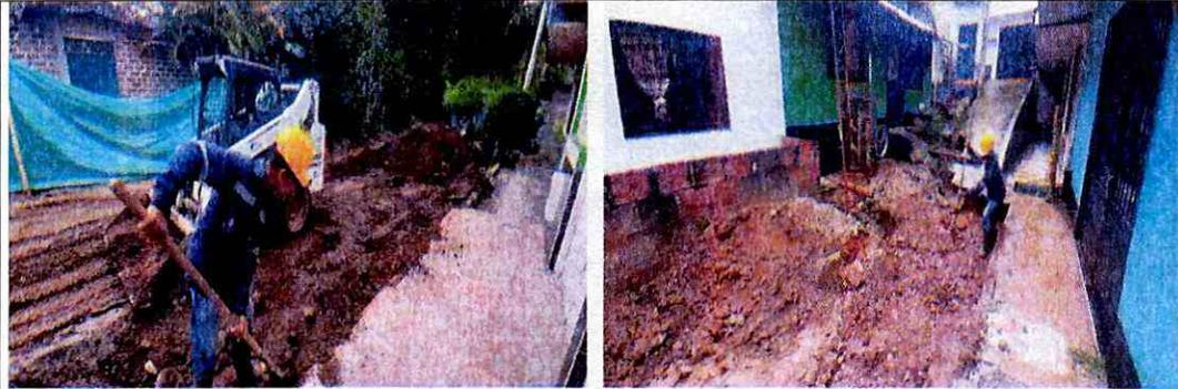
**Lleno y compactación con recebo en excavaciones red de alcantarillado.**
