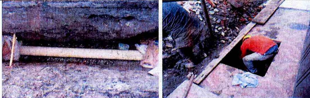
**Instalación tubería red principal de alcantarillado, elaboración de cajas de inspección aguas negras.**
