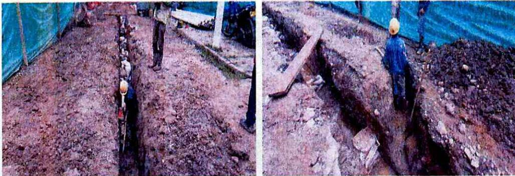
**Excavación para tubería red principal y acometida de alcantarillado.**
