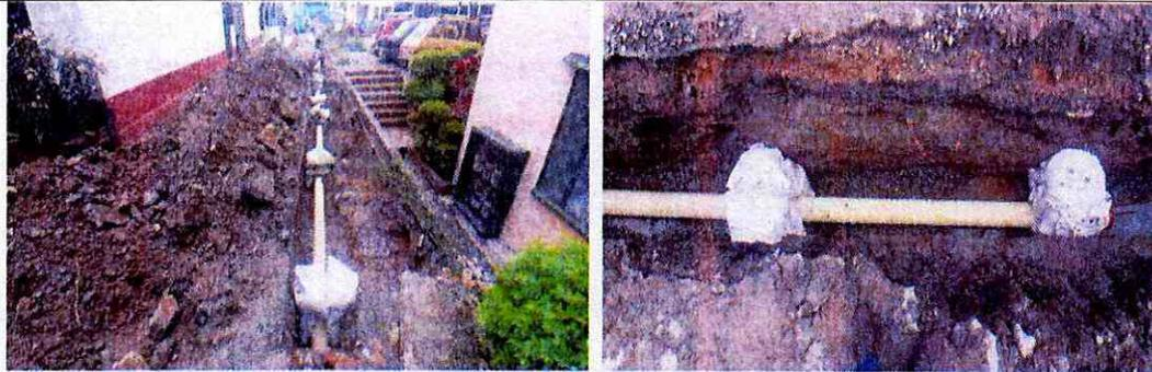
Instalación tubería red principal de alcantarillado.
