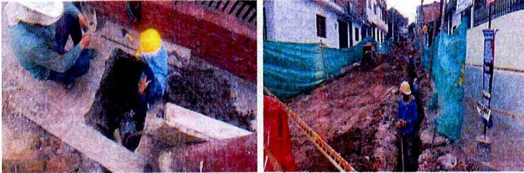
**Excavación para cajas de alcantarillado y red principal de acueducto.**
