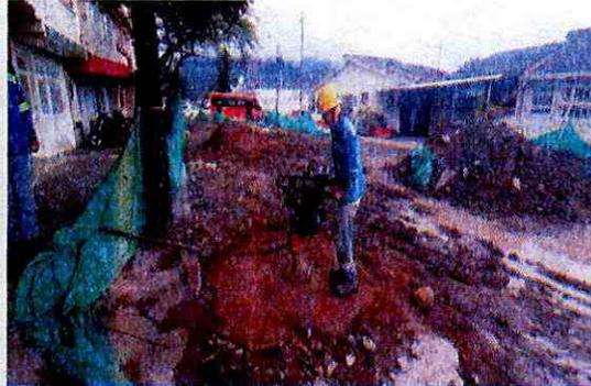
Elaboración de pozo de inspección aguas negras, lleno y compactación con recebo de excavaciones.
