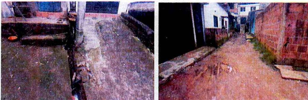
**Lleno y compactación de excavaciones alcantarillado.**
