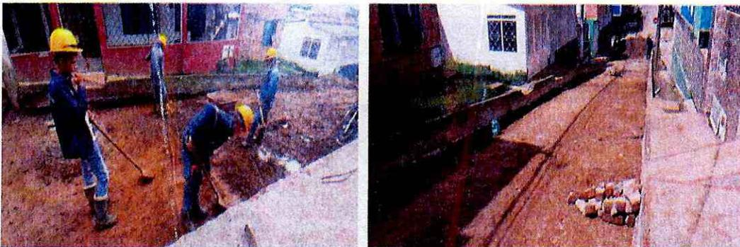
**Corte y excavación para cajeo de vía.**
