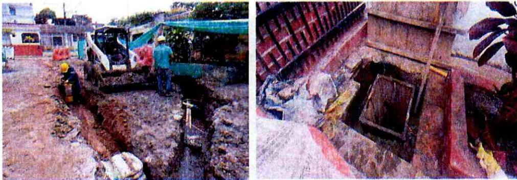
**Instalación de tubería acometidas de alcantarillado, lleno y compactación red alcantarillado.**
