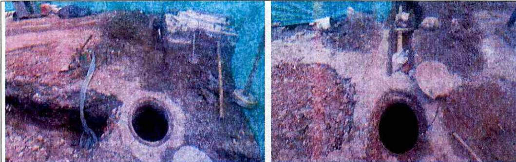
Excavación e instalación de tubería para sumideros.
