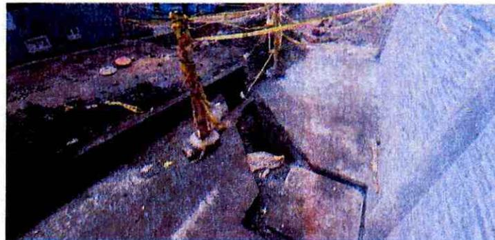
**Corte y excavación para acometida alcantarillado.**
