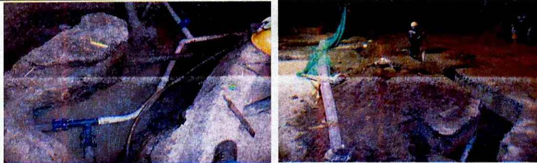
**Instalación de tubería y accesorios para empalme acueducto.**
