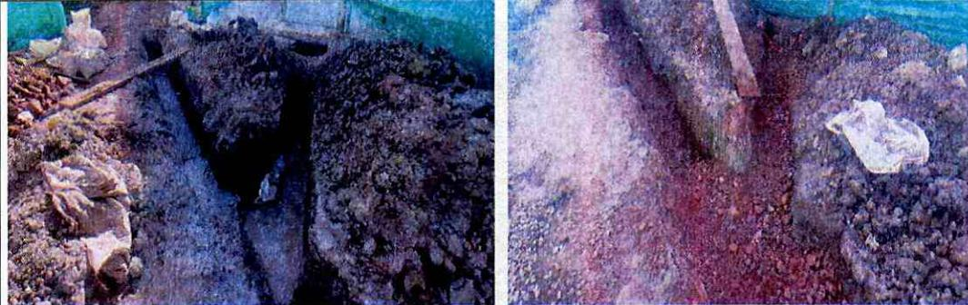
Recubrimiento en concreto y lleno con rebase de excavaciones de tubería red principal y acometidas alcantarillado.
