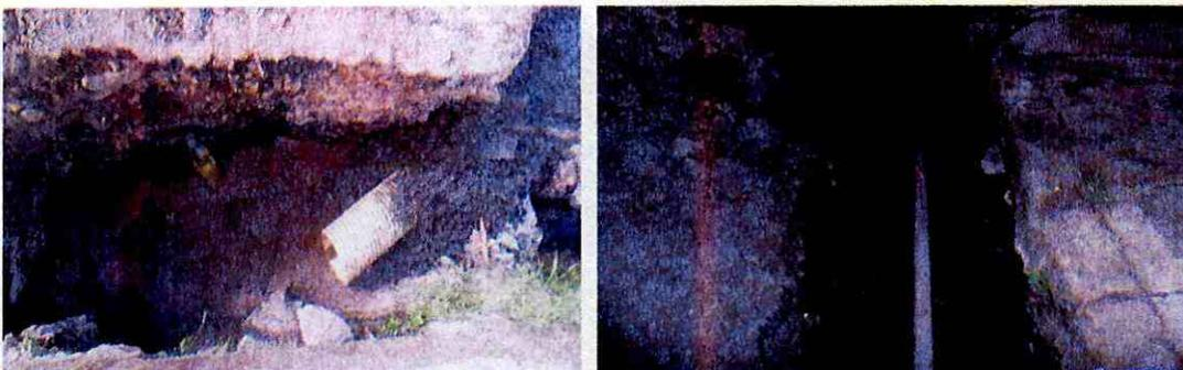
Instalación y recubrimiento de tubería sumideros aguas lluvias, instalación de tubería y accesorios para empalme acueducto.
