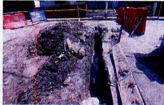
Excavación para tubería red principal de acueducto
