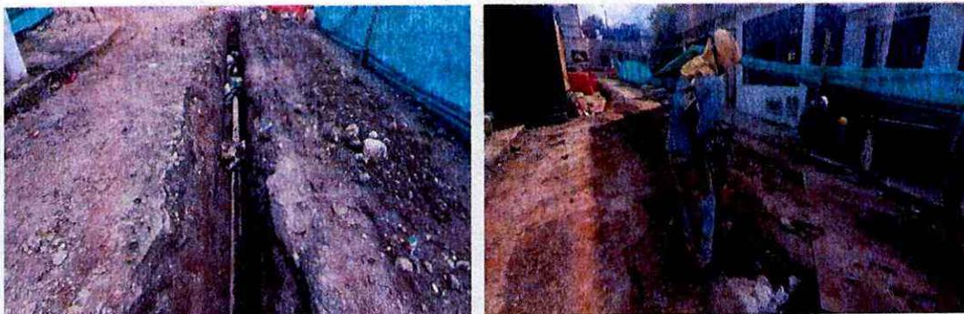
**Instalación para tubería red principal de alcantarillado, lleno y compactación.**
