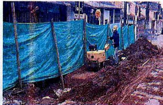
Corte, excavación e instalación de acometidas acueducto, Lleno y compactación de recebo red principal de acueducto.
