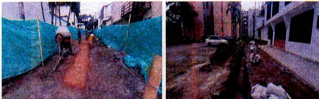
Lleno y compactación con rebase de excavación red de alcantarillado, excavación red principal de alcantarillado.
