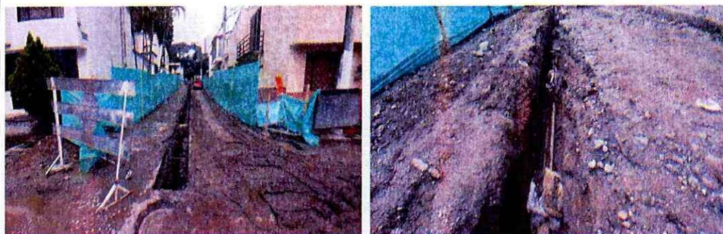
**Corte y excavación para red principal de alcantarillado.**
