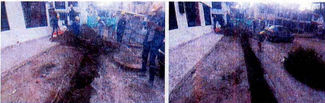
Lleno y compactación con recebo de excavación red de alcantarillado.
