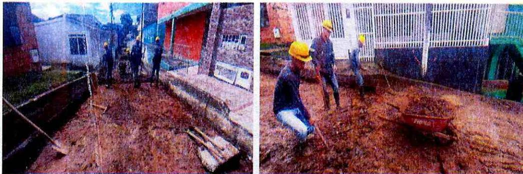
**Corte y excavación para cajeo de vía.**
