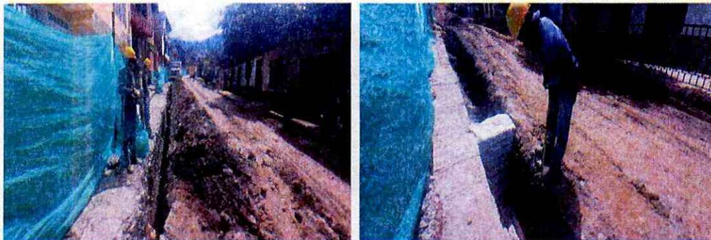
Excavación e instalación de tubería red principal de acueducto.
