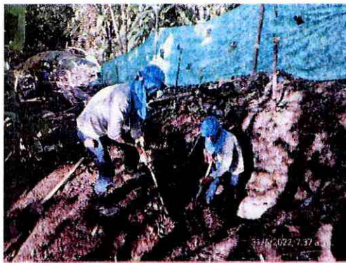
Foto 25. Personal con EPP. Distrito Pradera
