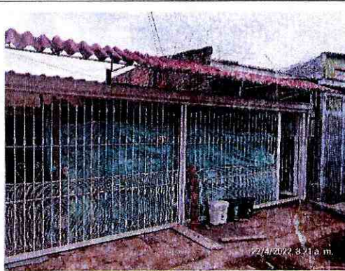
Foto 50. Campamento frente de obra América.
