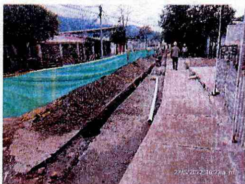
Foto 19. Actividad de instalación tubería.
