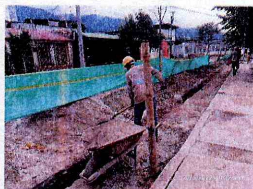
Foto 20. Actividad de instalación tubería.
