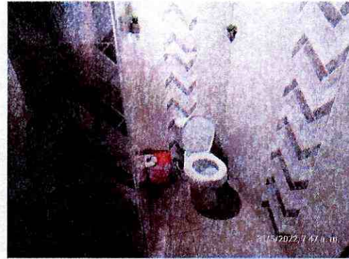
Foto 57. Baño Frente de obra Pradera.
