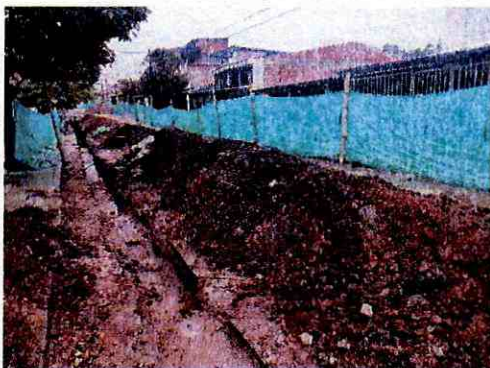
Foto 11. Labores de Excavación mecánica
