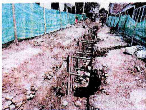
Foto 15. Instalación tubería con entibado
