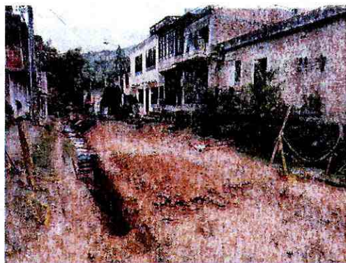
Foto 13. Instalación tubería.
