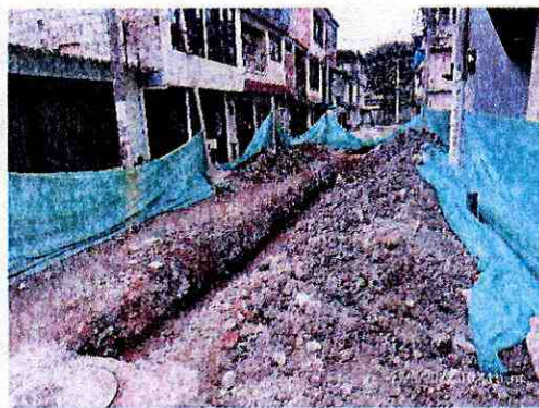
Foto 22. Instalación de tubería.
