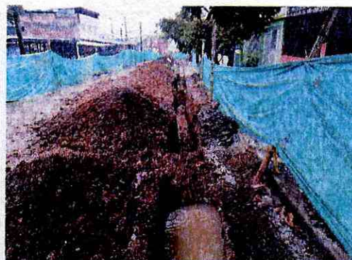
Foto 12. Instalación de tubería.
