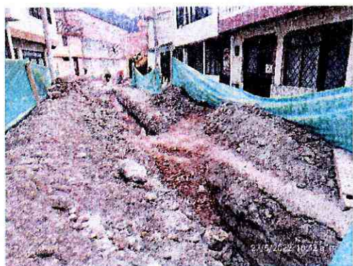
Foto 21. Instalación de tubería.
