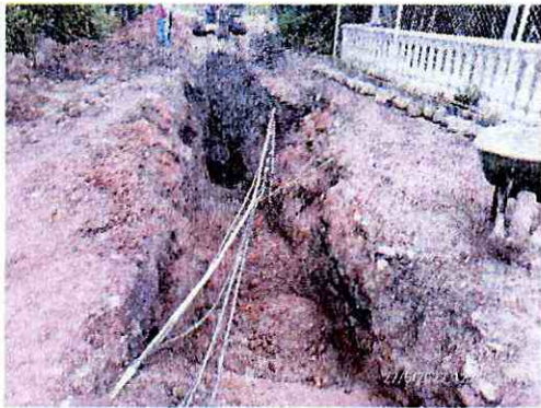
Foto 9. Labores de Excavación mecánica
