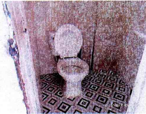
Foto 56. Baño Frente de obra Villa Claudia
