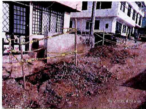
Foto 6. Instalación de domiciliarias
