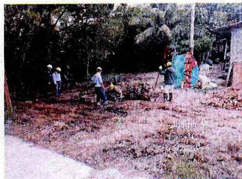
Foto 23. Construcción de pozos.
