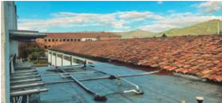
Figura 2. Cubierta del edificio BACAD 1. Fuente: Original de los autores.
