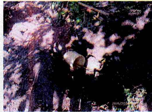
Foto 8. Instalación de tubería
