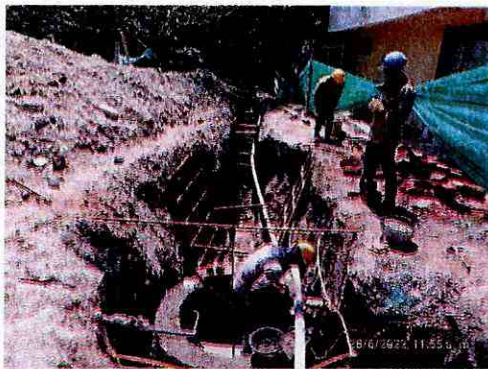
Foto 15. Construcción de pozos.
