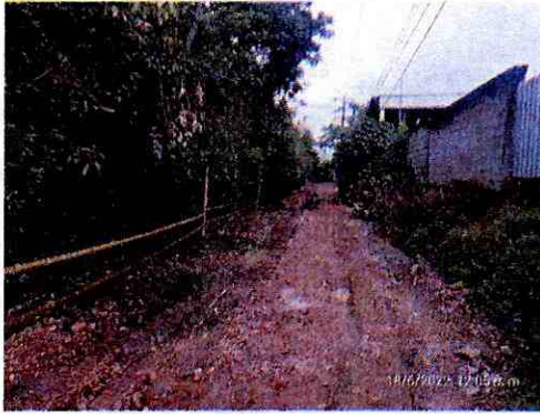
Foto 9. Labores de Excavación mecánica
