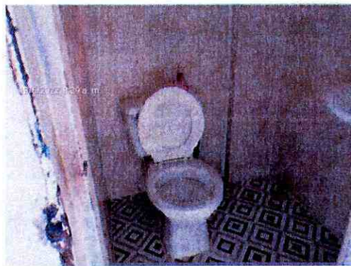
Foto 38. Baño Frente de obra Villa Claudia
