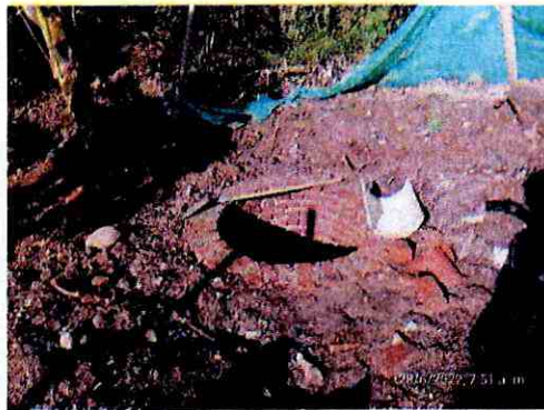
Foto 7. Construcción de pozo.
