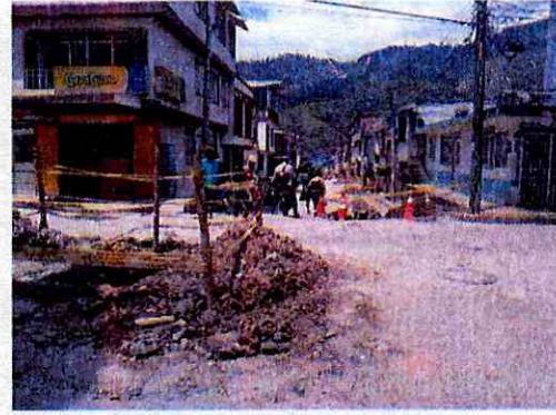
Foto 6. Excavación para empalmes.
