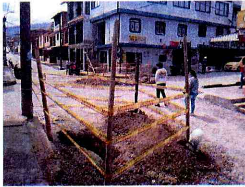
Foto 5. Excavación para empalmes.
