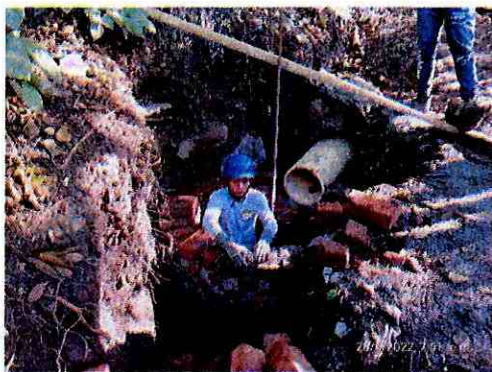
Foto 17. Personal con EPP. Distrito Pradera
