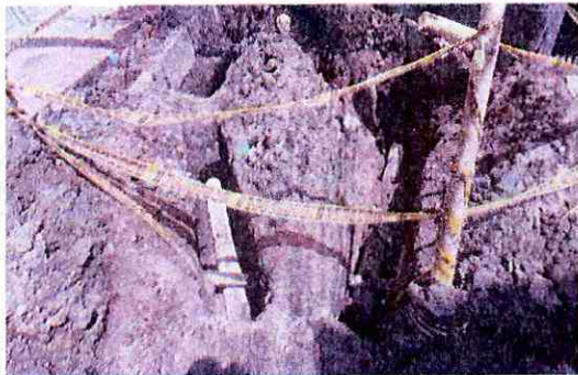
Instalación de tubería para sumideros aguas lluvias, elaboración de cajas para sumideros aguas lluvias.
