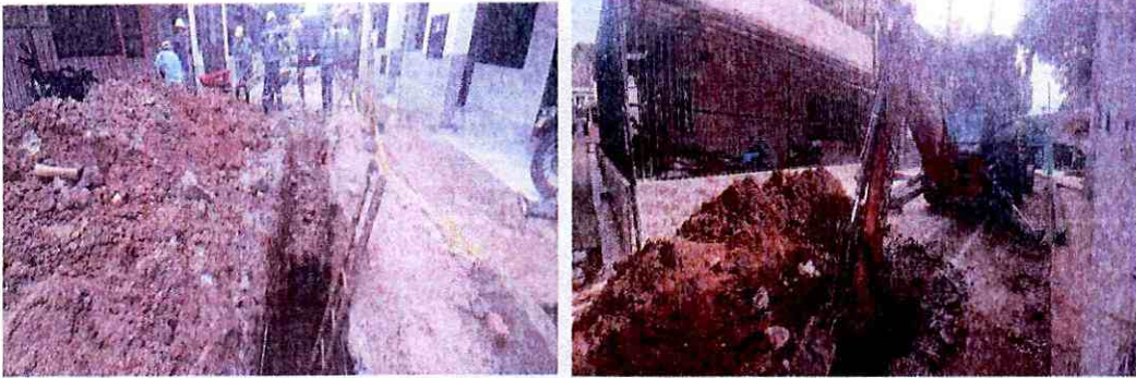
Corte y excavación para tubería alcantarillado.
