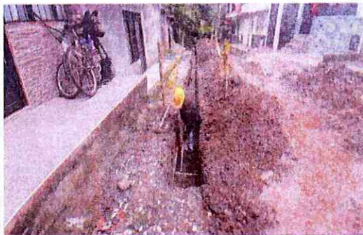
Excavación para tubería red principal de acueducto.
