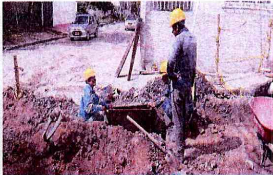
Instalación de tubería para sumideros aguas lluvias, elaboración de cajas para sumideros aguas lluvias.
