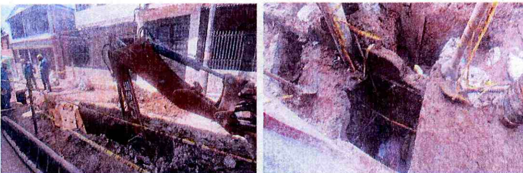
Excavación para tubería alcantarillado, excavación para caja de acometida alcantarillado.
