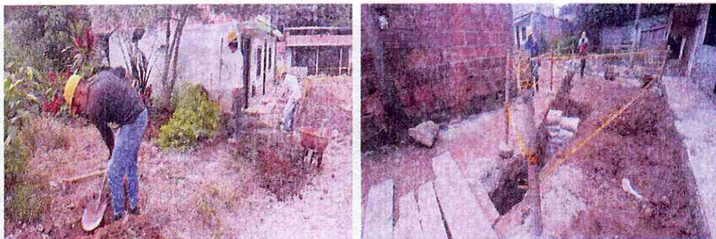
Excavación para tubería red principal de acueducto.
