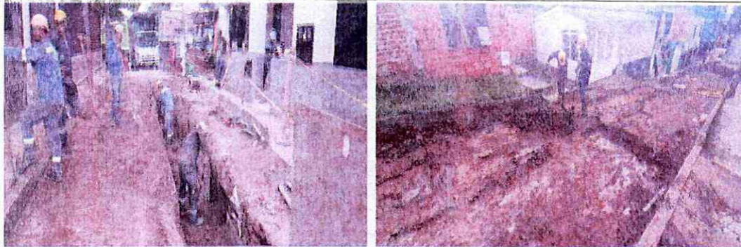
Lleno y compactación de recebo en excavación de tubería de aguas negras, excavación para cajeo vía.
