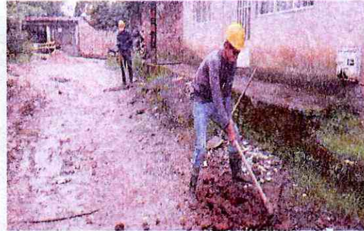
Excavación para tubería red principal de acueducto.
