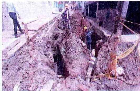
Excavación para tubería sumideros aguas lluvias, instalación de tubería para sumideros aguas lluvias.
