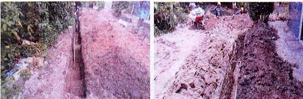
Lleno y compactación con recebo en red principal de acueducto, instalación de tubería red principal de acueducto.
