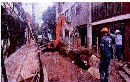
Elaboración de cajas para sumideros aguas lluvias, retiro de láminas entibado red de alcantarillado.
