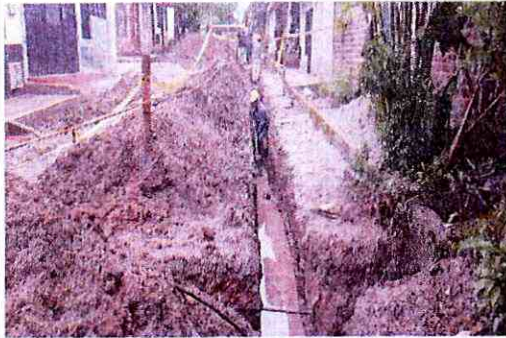
Excavación para tubería red principal de acueducto.
