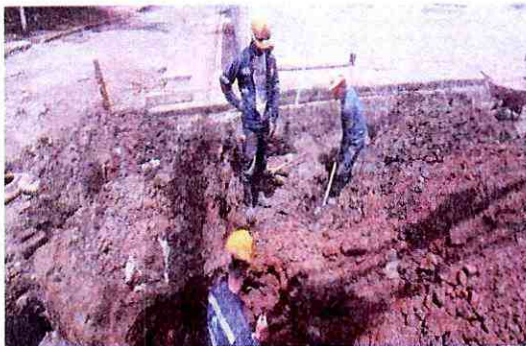
Excavación para tubería sumideros aguas lluvias, instalación de tubería para sumideros aguas lluvias.
