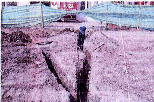
Excavación para tubería sumideros aguas lluvias.
