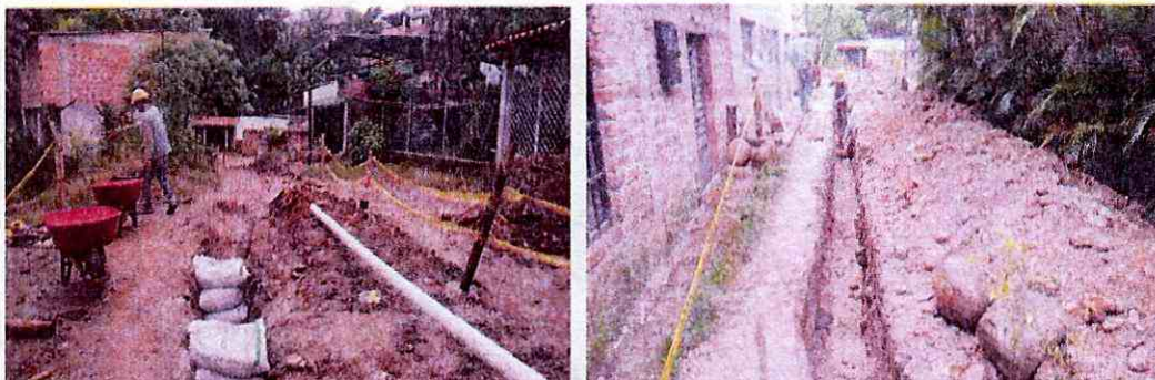
Lleno y compactación de excavación de tubería red principal de acueducto, excavación para tubería red principal de acueducto.
