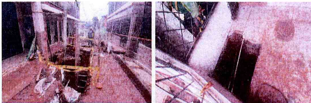
Excavación para tubería red de alcantarillado, excavación para caja de acometida alcantarillado.
