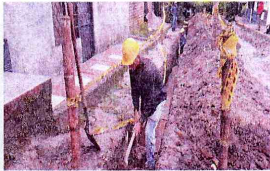
Excavación para tubería red principal de acueducto.
