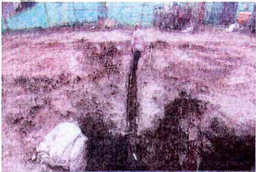
Instalación de collarines y acometidas de acueducto
