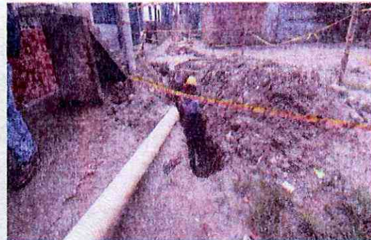
Excavación para tubería red principal de acueducto, cambio de tramo de tubería red principal de alcantarillado.
