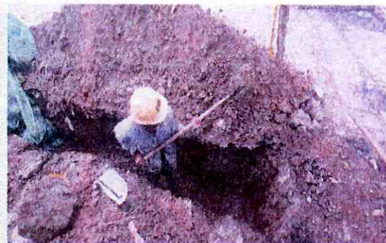
Excavación para tubería sumideros aguas lluvias.
