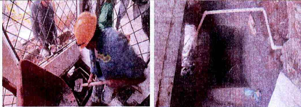
Elaboración de caja de inspección aguas negras.
