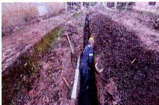
Excavación para tubería red principal de acueducto, cambio de tramo de tubería red principal de alcantarillado.
