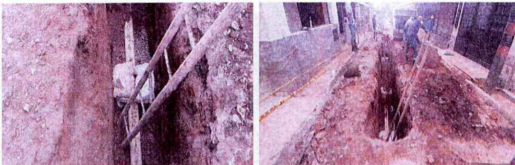
Instalación de tubería aguas negras.
