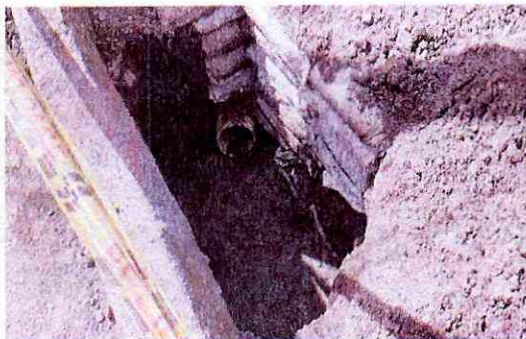
Elaboración de cajas para sumideros aguas lluvias, retiro de láminas entibado red de alcantarillado.
