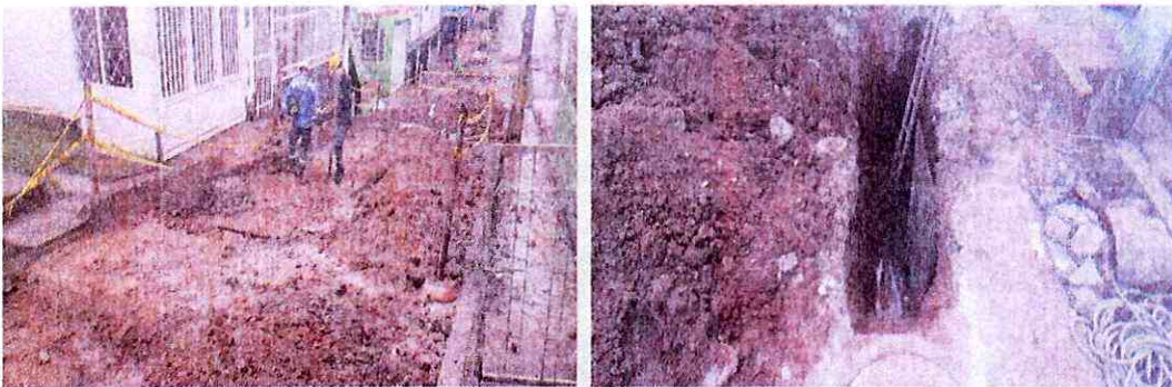
Excavación para cajero vía, excavación para tubería alcantarillado.
