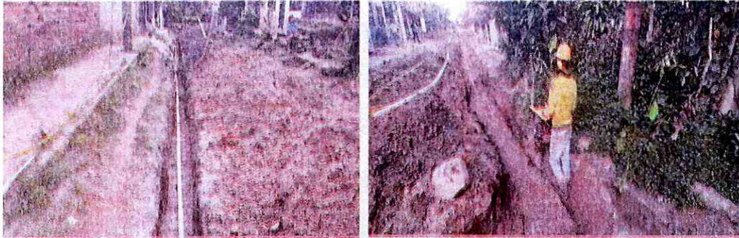
Instalación de tubería red principal de acueducto, lleno y compactación con recebo en red principal de acueducto.
