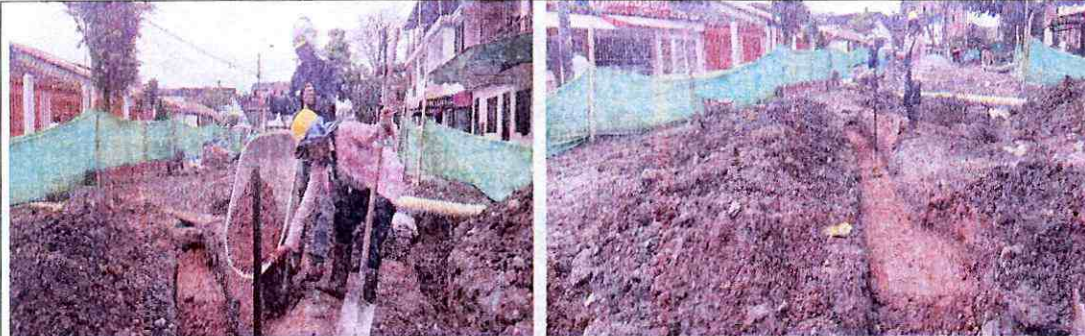
Lleno y compactación de recebo en excavación para tubería sumideros aguas lluvias.
