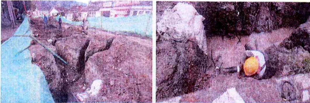
Excavación para tubería sumideros aguas lluvias, instalación de collarines y acometidas de acueducto.
