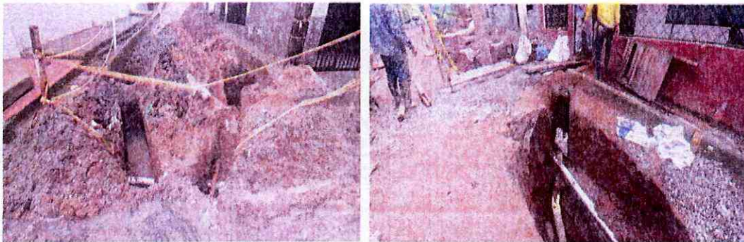
Excavación para tubería sumideros aguas lluvias, instalación de tubería acometida alcantarillado.
