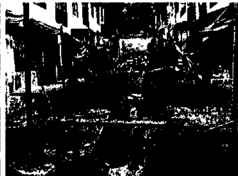
Excavación de zanjas de acometidas e instalación de tubería
