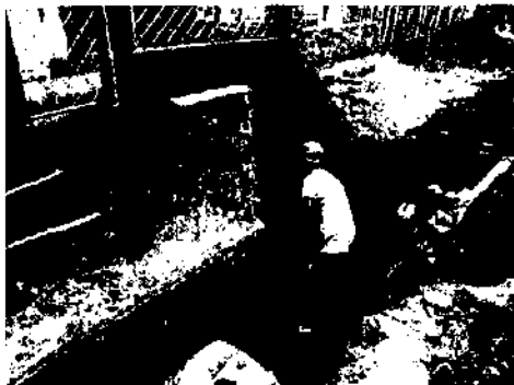
Excavación de zanjas de acometidas e instalación de tubería
