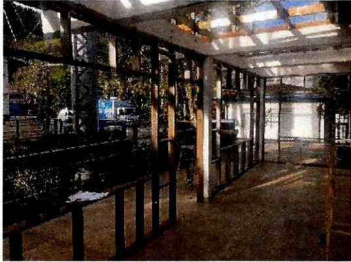
ESTRUCTURA METALICA MEZANINE 2 - PRIMER PISO
