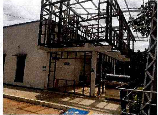
ESTRUCTURA METALICA MEZANINE 2 - PRIMER Y SEGUNDO PISO
