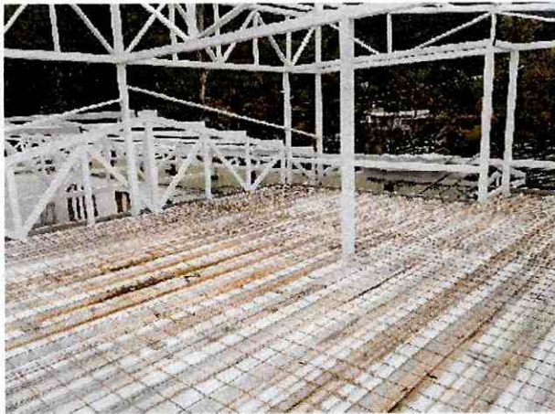
LOSA COMPUESTA METALDECK MEZANINE 1
