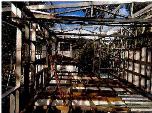
ESTRUCTURA METALICA MEZANINE 2 – PISO 2 Y ESTRUCTURA CUBIERTA
