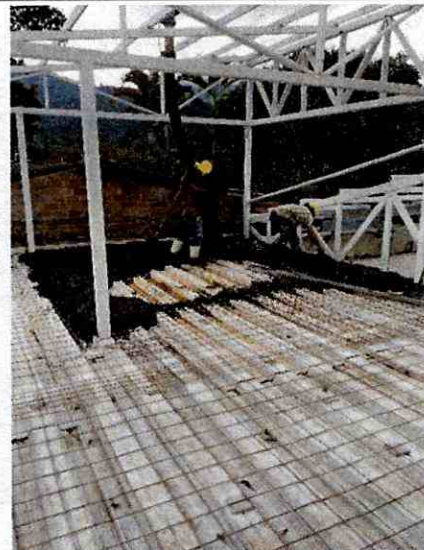
LOSA COMPUESTA METALDECK MEZANINE 1
