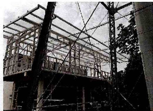
ESTRUCTURA METALICA MEZANINE 2 – PISO 2 Y ESTRUCTURA CUBIERTA
