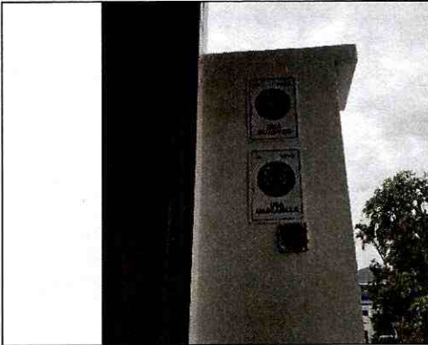
Figura No.1 señalización
