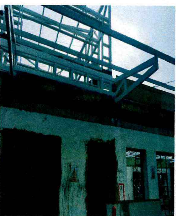
ARMADO DE ESTRUCTURA METALICA MEZZANINE
