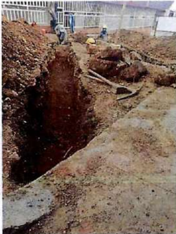
Se continua excavación de zanja para conexión de casa 19 de nuevo amanecer.
