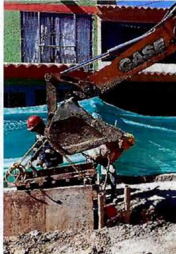
EXCAVACION MAQUINARIA ENTIBACION
