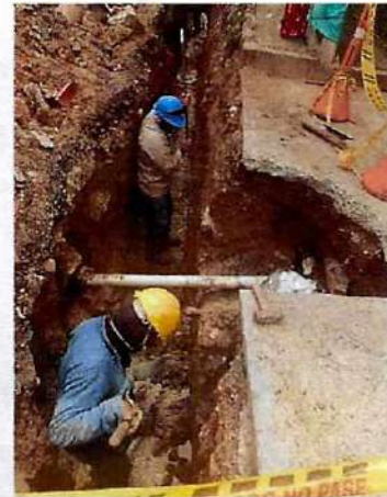
Se continua excavación manual en zanja de pozo 2 a pozo 3 de red principal 10" novaford
