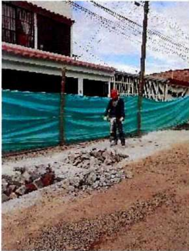
DEMOLICION ROTO MARTILLO
