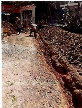
Se continua excavación de zanja para conexión de casa 19 de nuevo amanecer.
