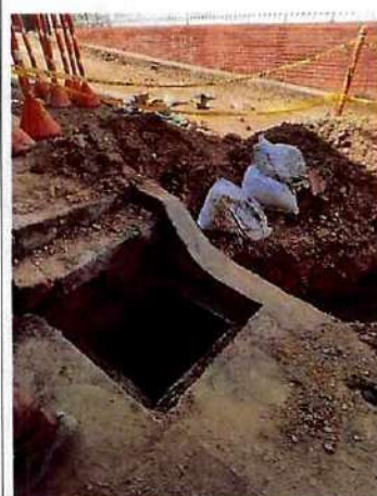
Se instalo tuberia 6" de conexión en acometida principal en manzana k casa 10 y manzana k casa 20 y se funden tapas y cajas domiciliarias.
