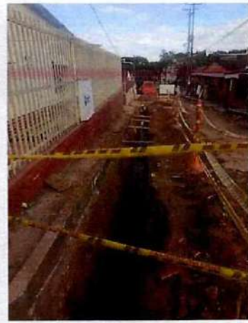
Revisión de conexión existente por parte de personal del IBAL / excavación manual
