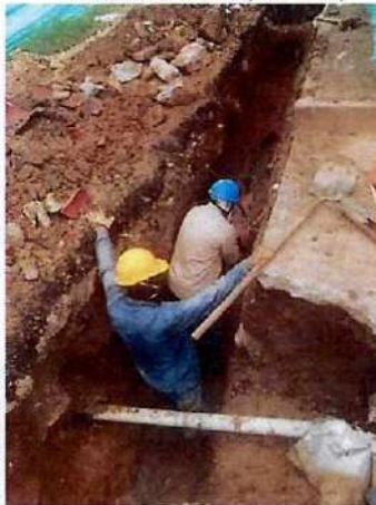
Se continua excavación manual en zanja de pozo 2 a pozo 3 de red principal 10" novaford
