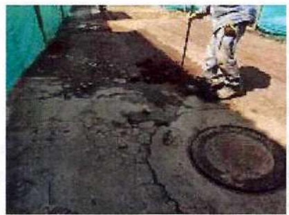
➤ Demolición manual de pavimento para zanja principal con un ancho de 0.70m
