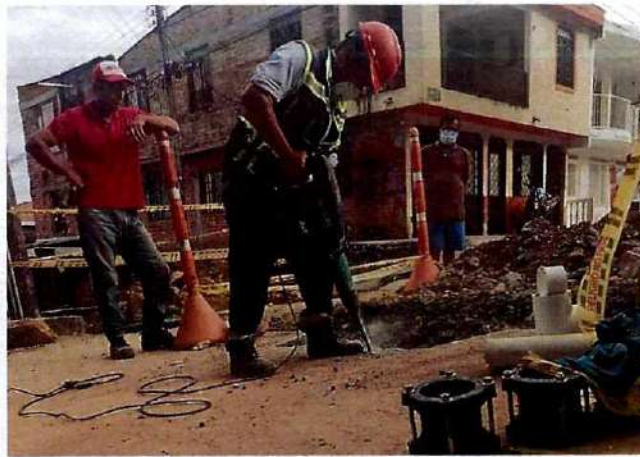
Demolición de concreto
