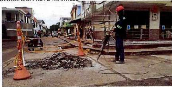
DEMOLICION ROTO MARTILLO
