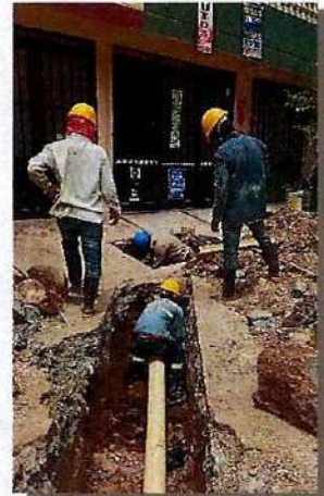
INSTALACIÓN DE TUBERÍA DE 6"
