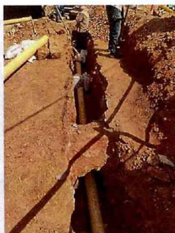
Se instalo tuberia 6" de conexión en acometida principal en manzana k casa 10 y manzana k casa 20 y se funden tapas y cajas domiciliarias.
