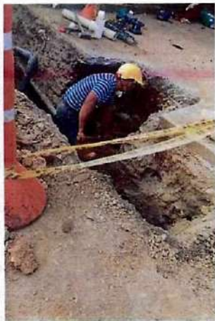
Revisión de conexión existente por parte de personal del IBAL / excavación manual
