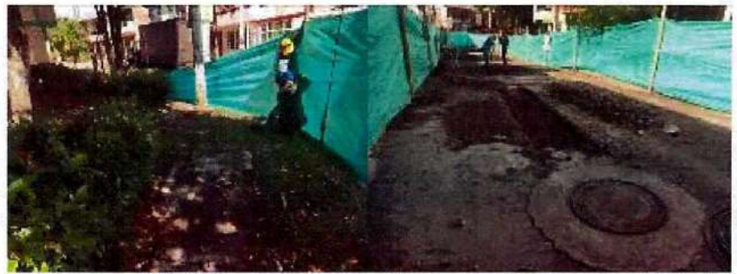
➤ Demolición manual de pavimento para zanja principal con un ancho de 0.70m
