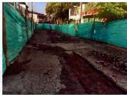
➤ Demolición manual de pavimento para zanja principal con un ancho de 0.70m
