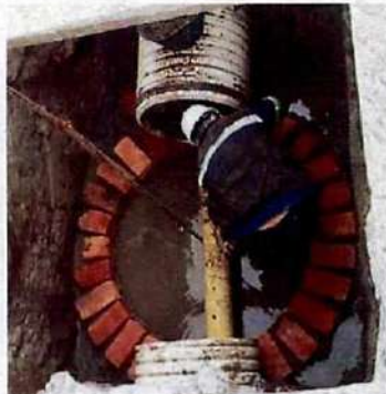
INICIO CONTRUCCION POZO PP3
