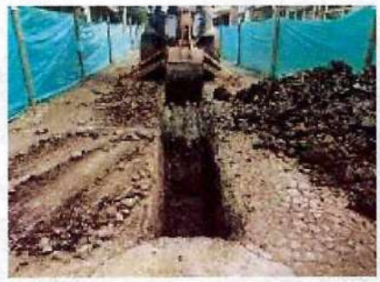
➤ vertimiento de grava en zanja principal para base de tubería de 10"
