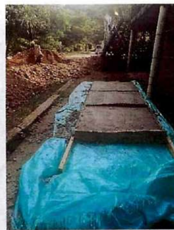
Se instalo tuberia 6" de conexión en acometida principal en manzana k casa 10 y manzana k casa 20 y se funden tapas y cajas domiciliarias.
