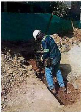
RELLENO Y COMPACTACIÓN EN RECEBO PARA ZANJAS DOMICILIARIAS
