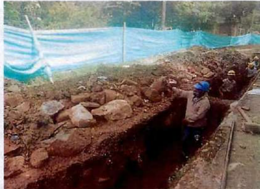
Demolición de material rocoso encontrado.
