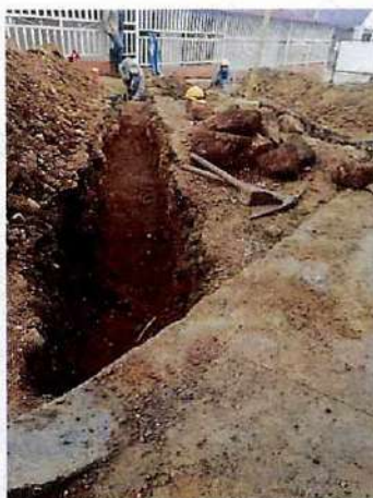
Se inicia excavacion para cjas domiciliaria en tramo en calle 115 con cra 19a y 19
