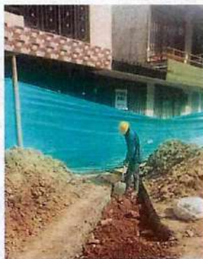
RELLENO Y COMPACTACIÓN EN RECEBO PARA ZANJAS DOMICILIARIAS
