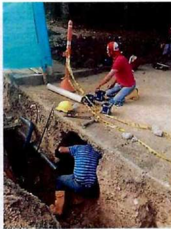
Revisión de conexión existente por parte de personal del IBAL / excavación manual
