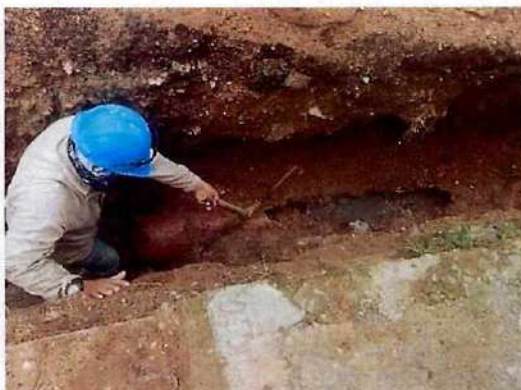
Desmonte de tubería existente
