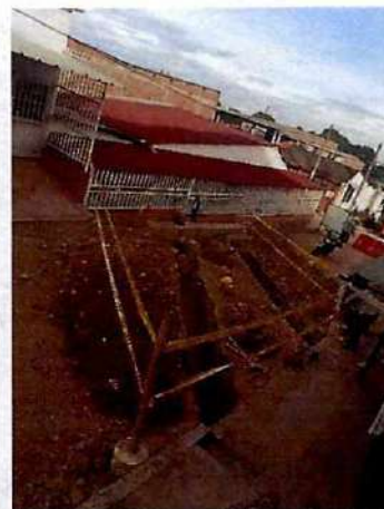
Se inicia excavacion para cjas domiciliaria en tramo en calle 115 con cra 19a y 19
