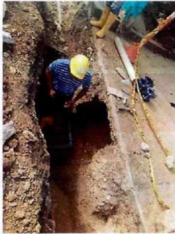
Verificación de tubería a inhabilitar
