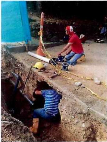
Verificación de tubería a inhabilitar
