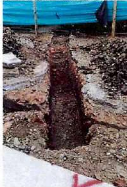
EXCAVACION MANUAL ZANJA
