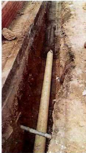
fundida de revestimiento del tramo requerido entre pozo 2 y pozo 1
