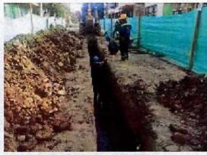
➤ vertimiento de grava en zanja principal para base de tubería de 10"
