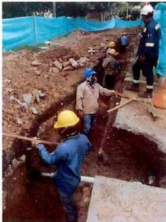
Se continua excavación manual en zanja de pozo 2 a pozo 3 de red principal 10" novaford
