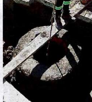
RESANE DE POZO
