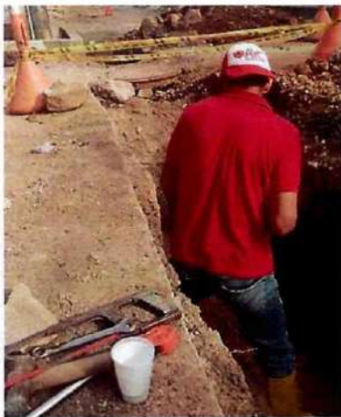
Verificación de conexión al pozo
