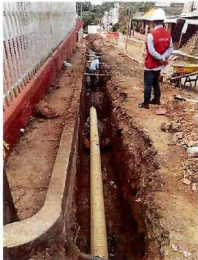
fundida de revestimiento del tramo requerido entre pozo 2 y pozo 1
