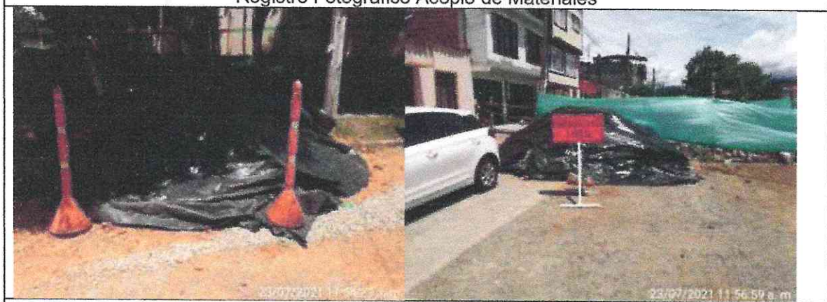
Registro Fotográfico Acopio de Materiales
