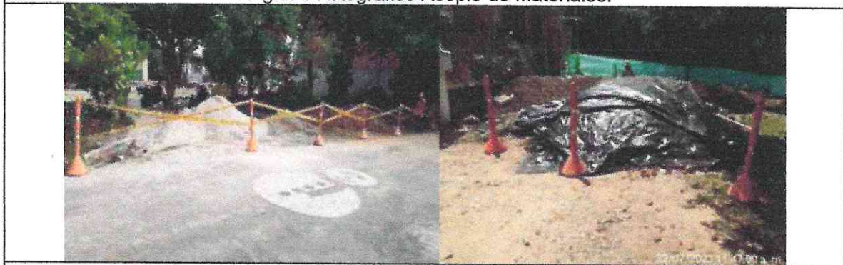
Registro Fotográfico Acopio de Materiales
