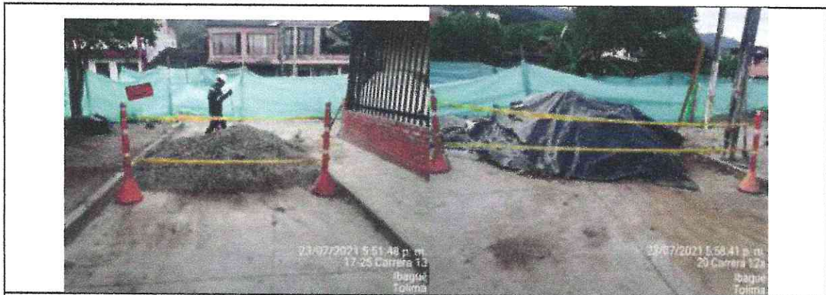
Registro Fotográfico Acopio de Materiales.
