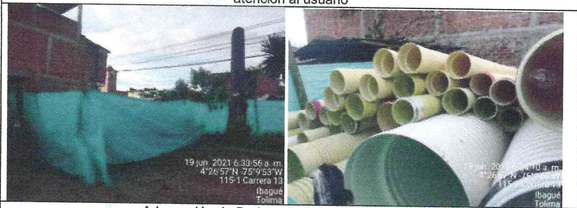
Adecuación de Bodega en Instalación Temporal.
