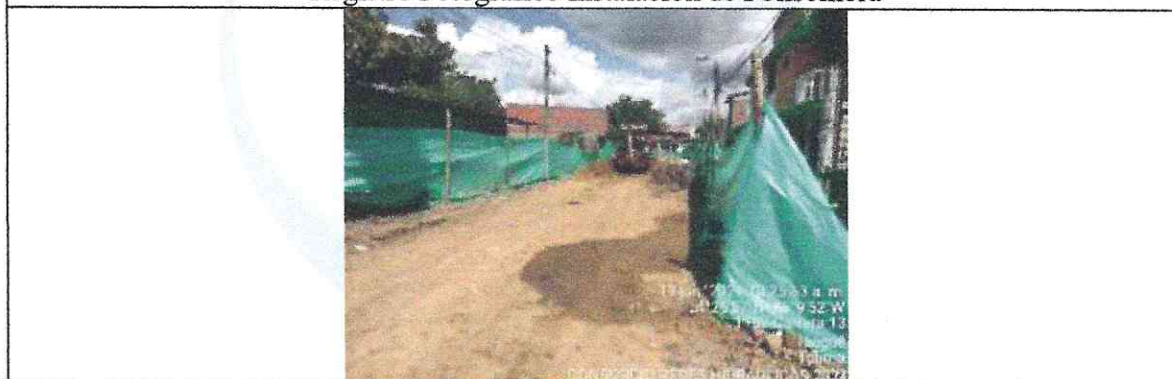
Registro Fotográfico Instalación de Polisombra
