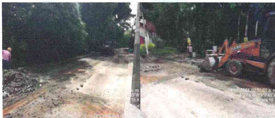
Registro Fotografico 43 Limpieza de residuos de construcción y demolición
