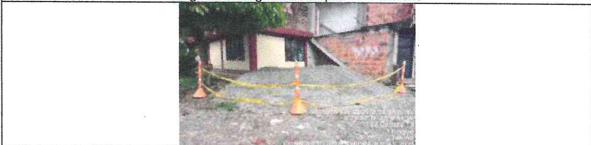
Registro Fotográfico Acopio de Materiales Señalizado
