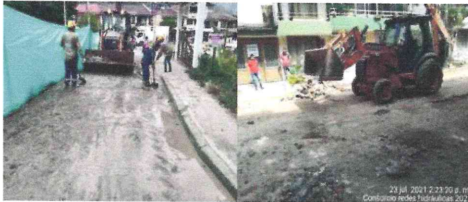
Registro Fotografico 44 Limpieza de RCD
