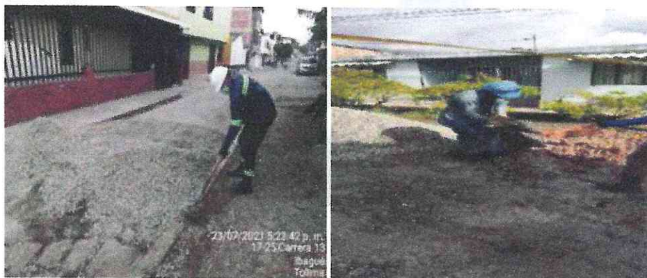
Registro Fotografico 46 Registro fotografico
