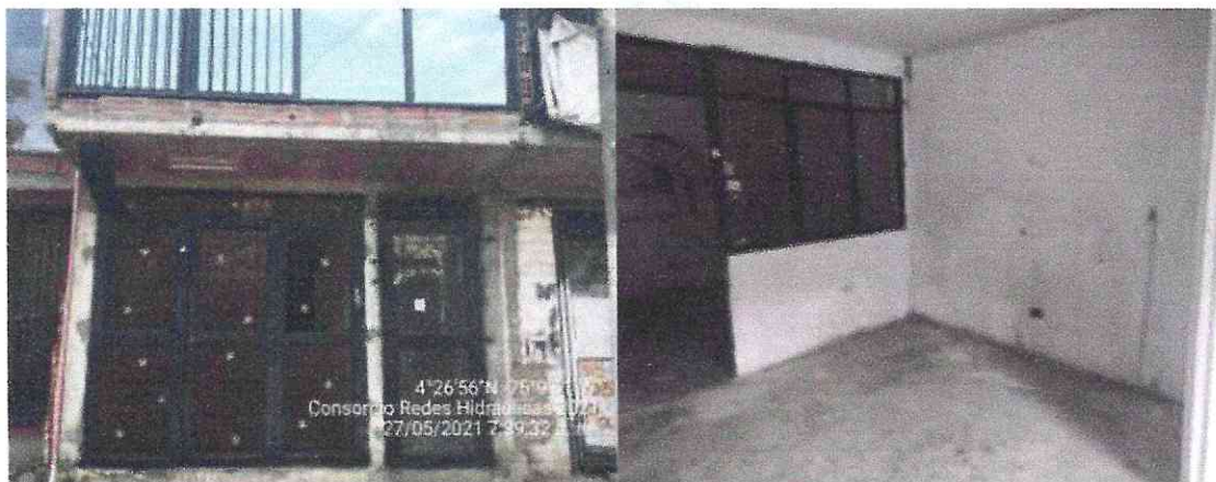
Registro Fotografico 41 Antes y después del Proyecto Punto de Oficina y Bodega.
