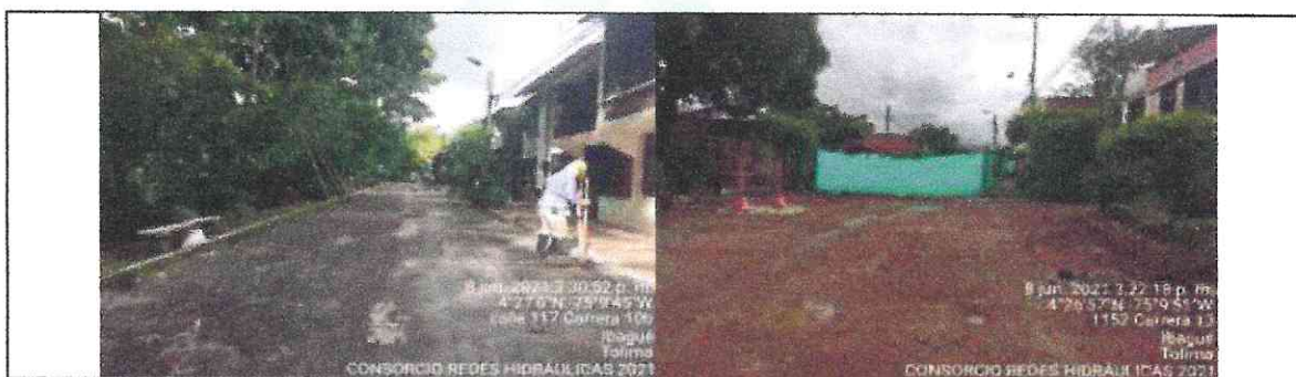
Registro Fotográfico Instalación de Polisombra
