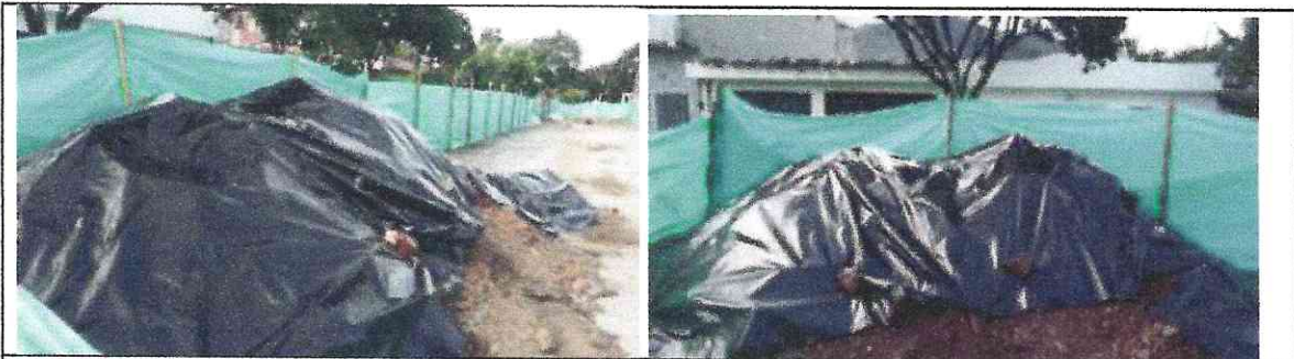
Registro Fotográfico Materiales Cubiertos con Polietileno
