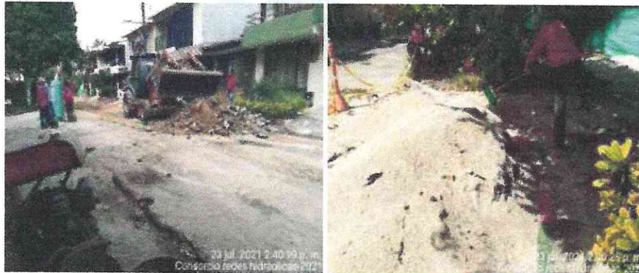
Registro Fotografico 45 Limpieza frentes de Trabajo
