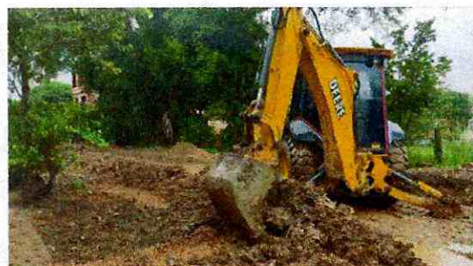
➤ Limpieza de tramo con retroexcavadora
