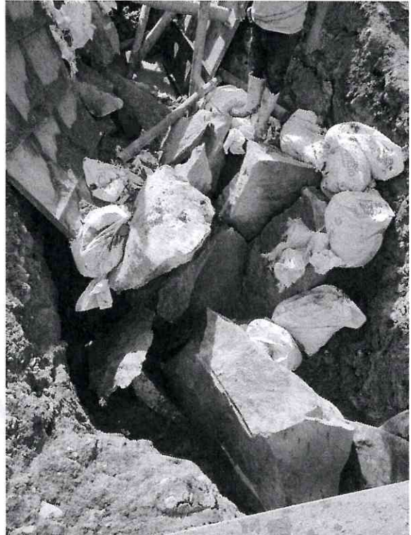
DEMOLICION DE ROCAS CON CEMENTO EXPANSIVO
