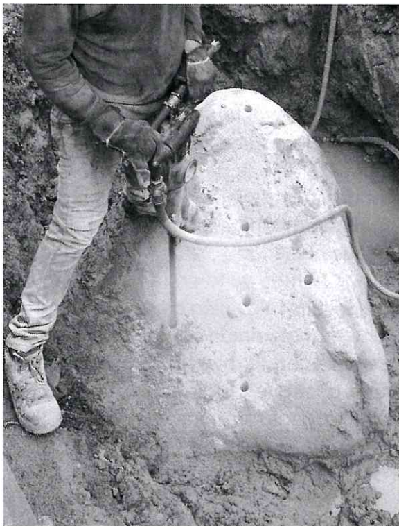
DEMOLICION DE ROCAS CON CEMENTO EXPANSIVO
