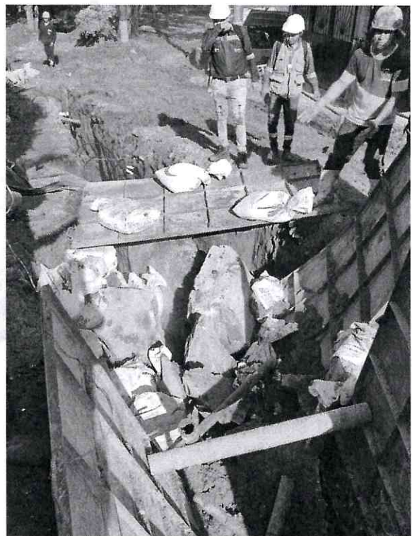
DEMOLICION DE ROCAS CON CEMENTO EXPANSIVO
