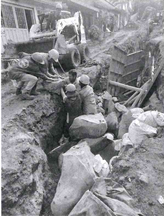
DEMOLICION DE ROCAS CON CEMENTO EXPANSIVO
