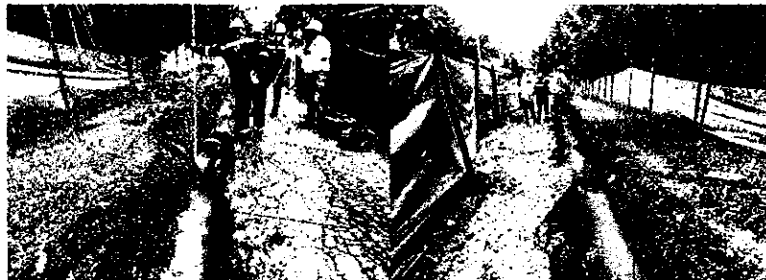
Nivelación de tubería por parte del equipo de topografía con participación de la interventoría
