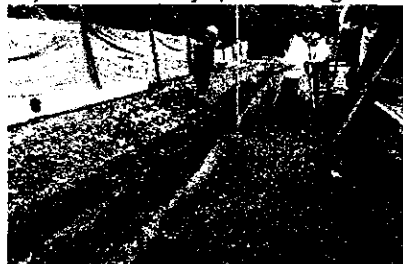
Nivelación de tubería y tendido de eje para el segundo y tercer tubo de 12"
