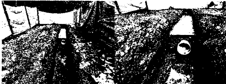
Fundida de revestimiento para tubo de 12"
