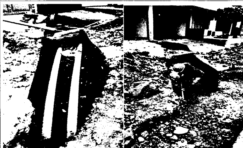
Tubería pvc 6" domiciliaria. Excavación manual para domiciliaria alcantarillado
