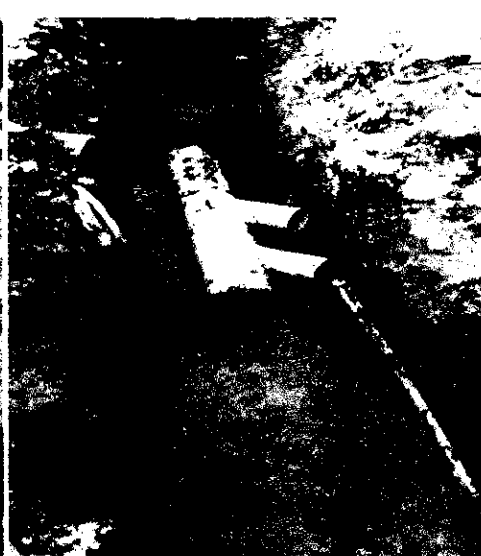
Preparación de zanja para instalación de tubería. Concreto de revestimiento
