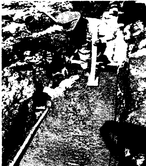
Preparación de zanja para instalación de tubería. Concreto de revestimiento
