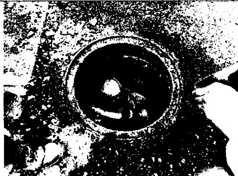
Verificación de diámetros de tubería
