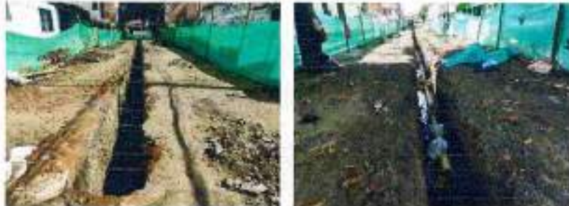
➤ Lleno y compactación en recebo de zanja principal
