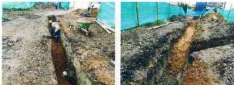
➤ Lleno y compactación en recebo de zanja principal
