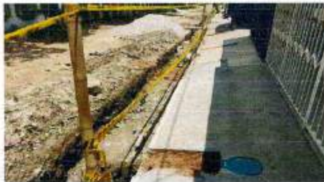
➤ Relleno con recebo de zanjas para mangueras de agua
