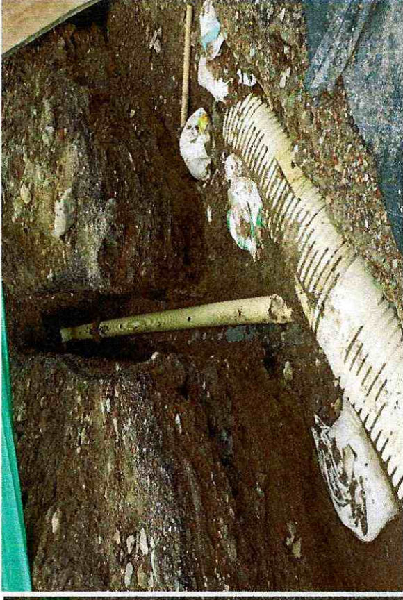
TRABAJOS REALIZADOS EN EL TRAMO ADICIONAL
