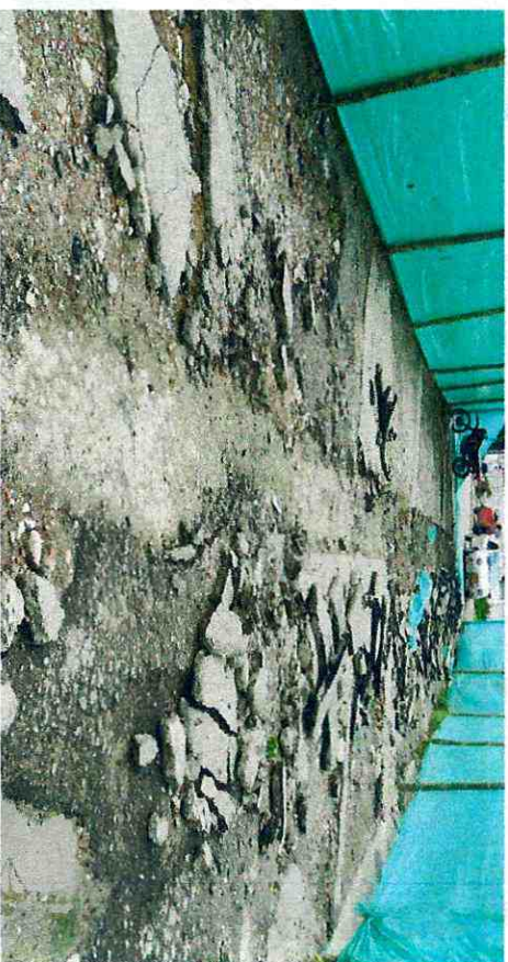
TRABAJOS REALIZADOS EN TRAMO 11
