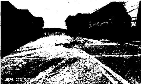
ROTURA PAVIMENTO RÍGIDO E= 0,10 M.
