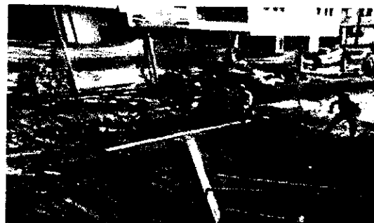
SUMINISTRO E INSTALACION DE TUBERIA PVC PRESION RDE 21 – DIAMETRO 3" ACUEOUCTO
