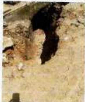
EXCAVACIONES A MANO ACOMETIDAS SANITARIA
