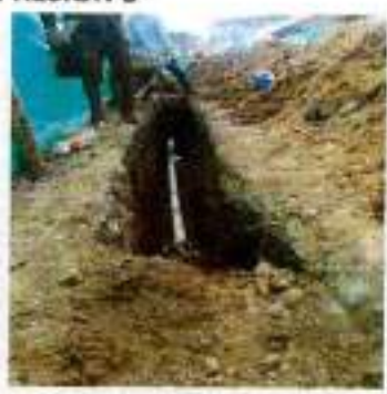
EXCAVACIONES MANUALES ACOMETIDAS SANITARIAS
