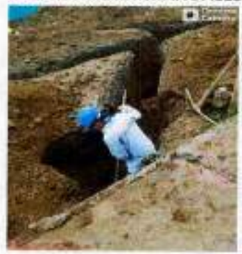
EXCAVACIONES MANUALES ACOMETIDAS SANITARIAS
