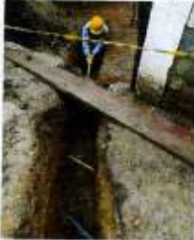
EXCAVACIONES A MANO ACOMETIDAS SANITARIA
