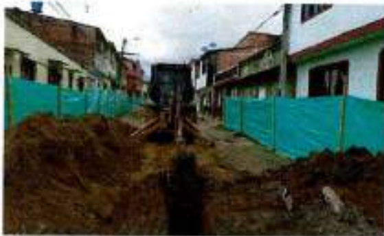
EXCAVACIONES A MAQUINA
