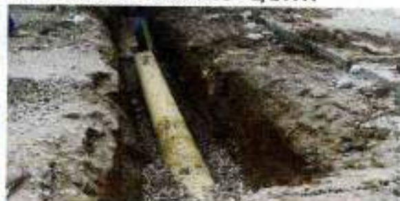
SUMINISTRO E INSTALACION LECHO EN GRAVA PARA CAMA DE TUBERIA D= 1/2 A 3/4
