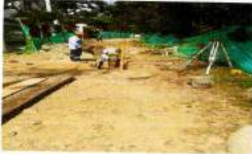
SUMIN. DE RECEBO EN ZANJA
