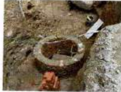
CONSTRUCCION DE POZOS DE INSPECCION
