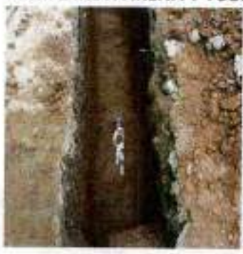
EXCAVACIONES MANUALES ACOMETIDAS SANITARIAS
