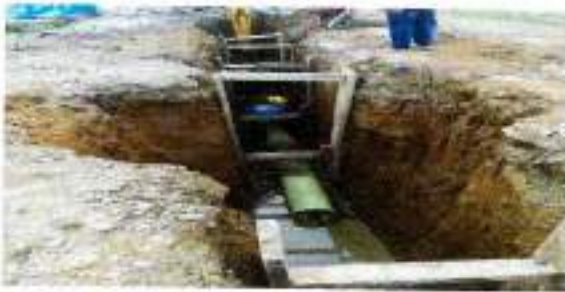
SUMINISTRO E INSTALACION LECHO EN GRAVA PARA CAMA DE TUBERIA D= 1/2 A 3/4
