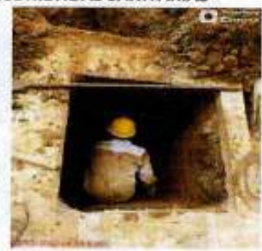
EXCAVACIONES MANUALES ACOMETIDAS SANITARIAS
