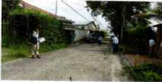
VISITA TECNICA INICIAL
