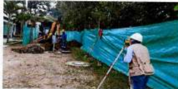
LOCALIZACION Y REPLANTEO
