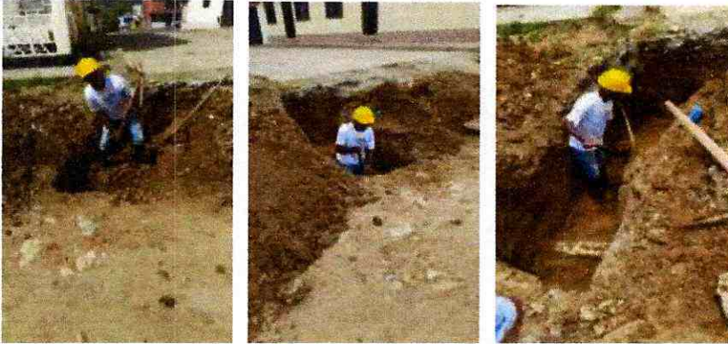
Excavación manual empalme calle 33 sobre la vía.
