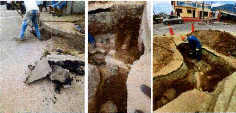
Excavación manual empalme calle 34 sobre la vía.
