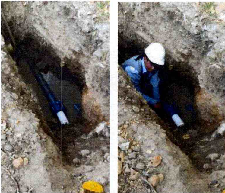
Empalmes calle 109 frente a clínica UMIT.
