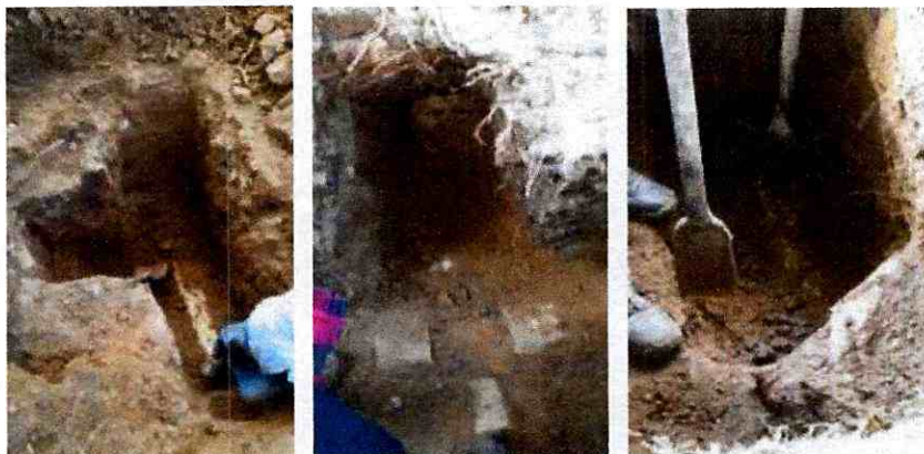
Excavación manual empalme calle 32A sobre zona verde (antejardín)
