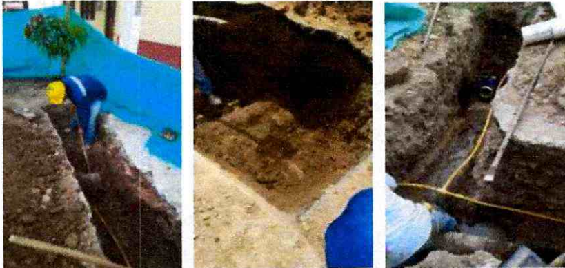
Excavación manual empalme calle 32 sobre zona verde (antejardín)
