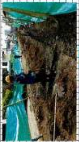
De las 1, 2m los primeros 35 cm son en conglomerado ya que con 10 de pavimento flexible y 25 de recibo
