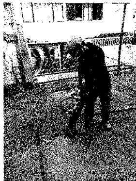
CORTE PAVIMENTO RIGIDO CORTADORA 40CISA K00+00 A K00+3.5
