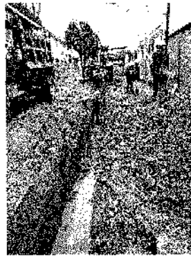
PROCESO DE EXCAVACION E INSTALACION DE LA TUBERIA NOVAFOR
