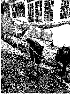
Excavación para domiciliaria estado de la tubería de agua potable en asbesto cemento
