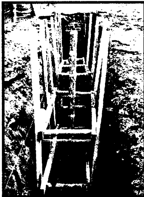
Ilustración 25. instalación de entibados para seguridad en zanjas
