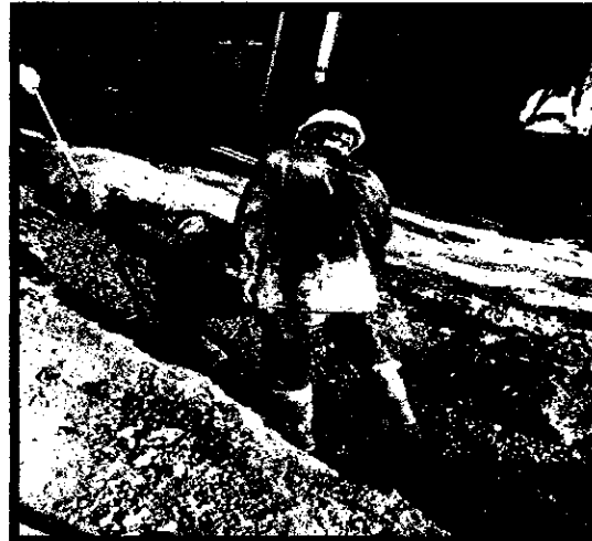
Ilustración 36. Recebo compactado sobre zanjo principal
