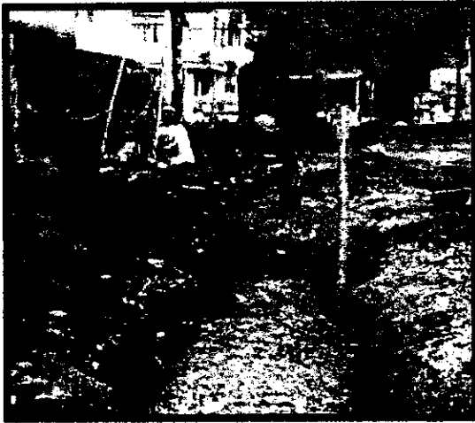
Ilustración 6. Receba en zanja compactada
