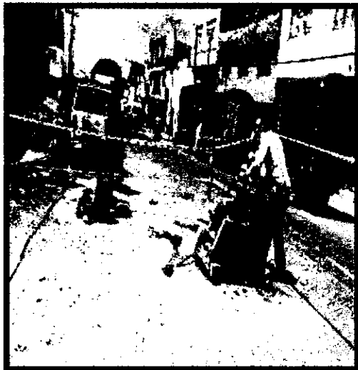
Ilustración 8. Corte de pavimento flexible y rígido
