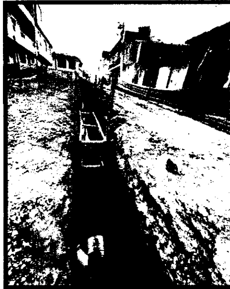
Ilustración 35. Entibado discontinua en madera
