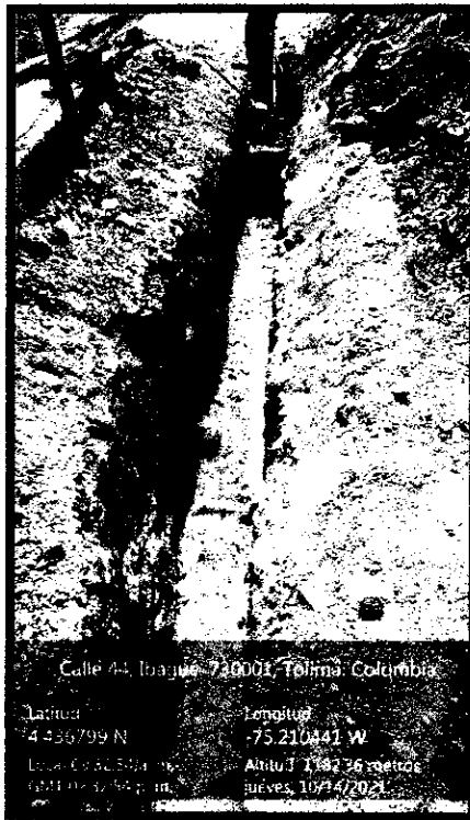
Ilustración 50. Excavación manual, Lecho de arena e instalación de tubería de 3" acueducto
