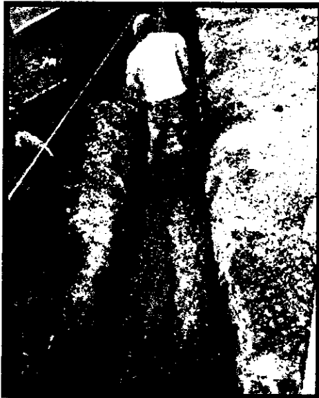
Ilustración 55. Compactación de recebo en zanja
