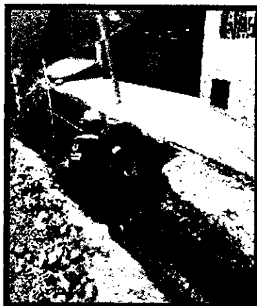
Ilustración 86. Instalación de recebo compactada
