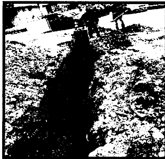
Ilustración 50. Suministro e instalación de lecho en grava
