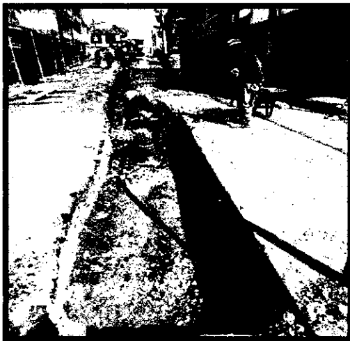
Ilustración 36. Recebo compactado sobre zanjo principal
