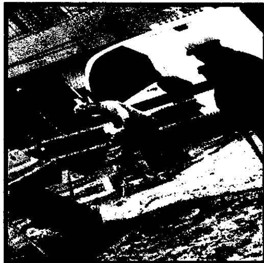
Ilustración 8. Corte de pavimento flexible y rígido
