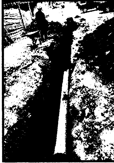
Ilustración 47. Suministra e instalación de tubería principal de 12"
