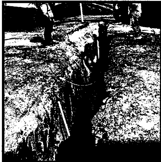
Ilustración 103. Suministro e Instalación de triturado y tubería de 12"
