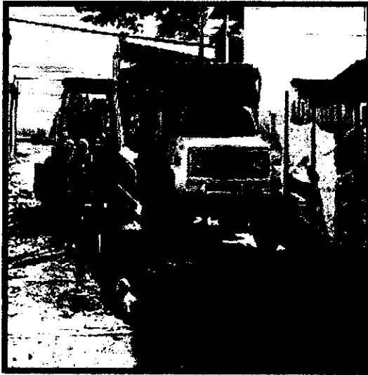
Ilustración 54. Cargue y retiro de sobrantes provenientes de excavaciones
