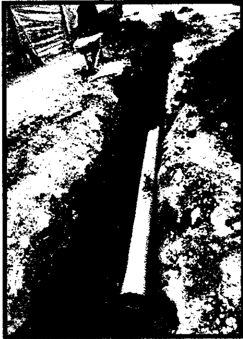
Ilustración 47. Suministra e instalación de tubería principal de 12"
