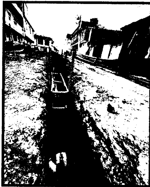
Ilustración 106. Entibado discontinuo en madera
