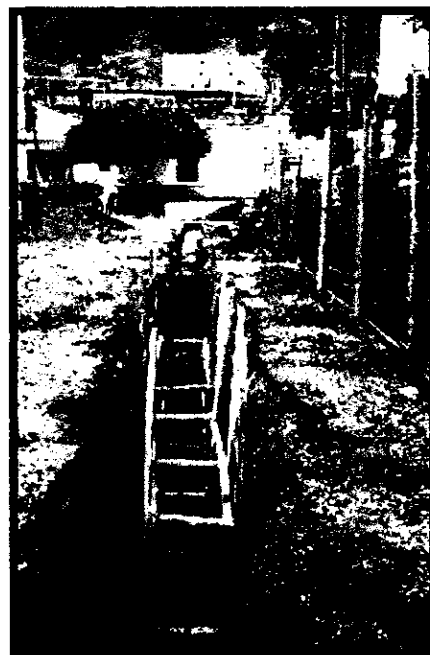
Ilustración 25. instalación de entibados para seguridad en zanjas
