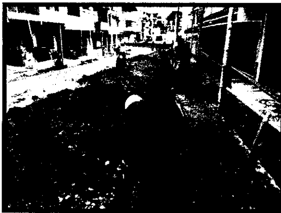
Ilustración 29. Excavación y suministro de receba
