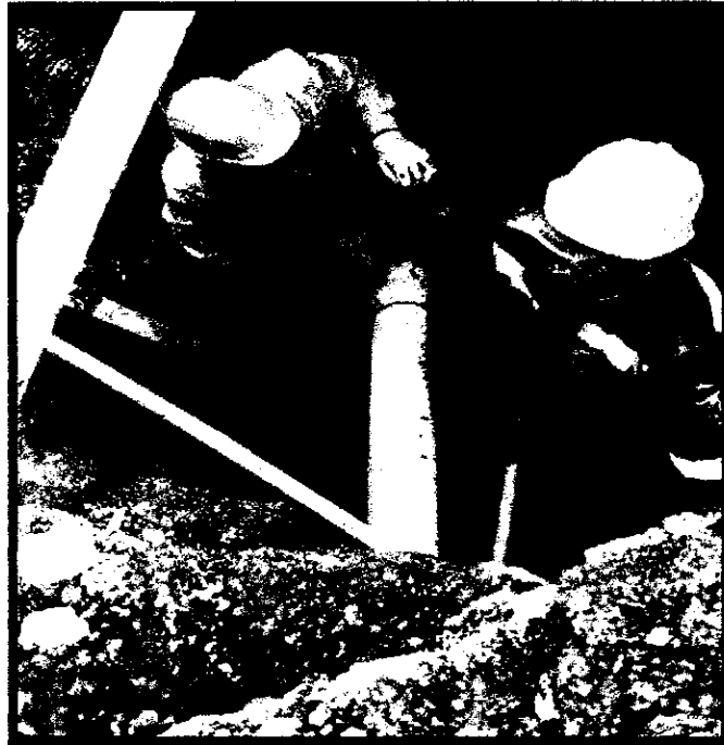
Ilustración 89. Instalación de tubería de 6" para domiciliarias
