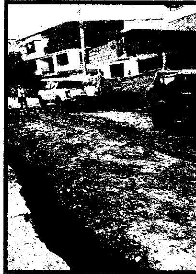
Ilustración 42. Excavación de red principal de acueducta prof 1,20 a 1,30 mts
