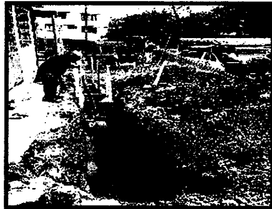
Ilustración 9. Cargue y retiro de sobrantes provenientes de excavaciones
