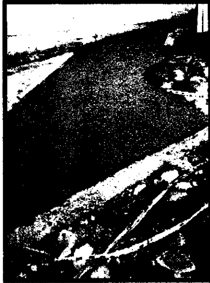
Ilustración 24. Anden en concreto de 2.500 psi
