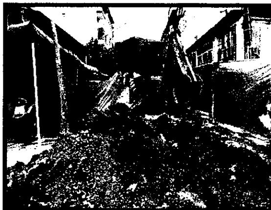
Ilustración 14. Cerramiento en guadua y palisombra
