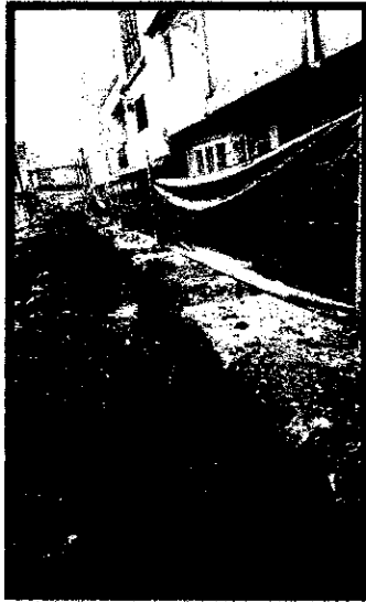
Ilustración 42. Excavación de red principal de acueducta prof 1,20 a 1,30 mts
