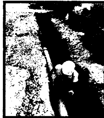
Ilustración 19. instalación de tubería 10"
