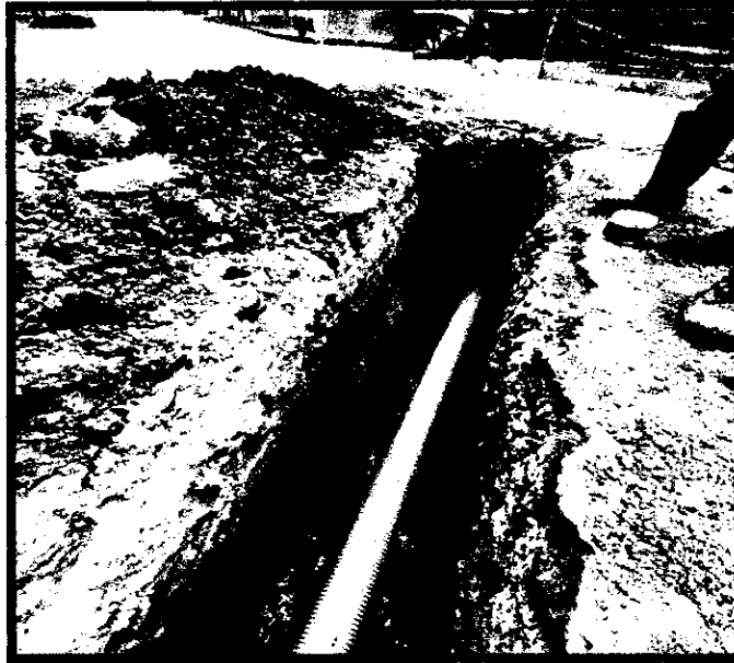
Ilustración 104. Suministro e Instalación de tubería de 6"
