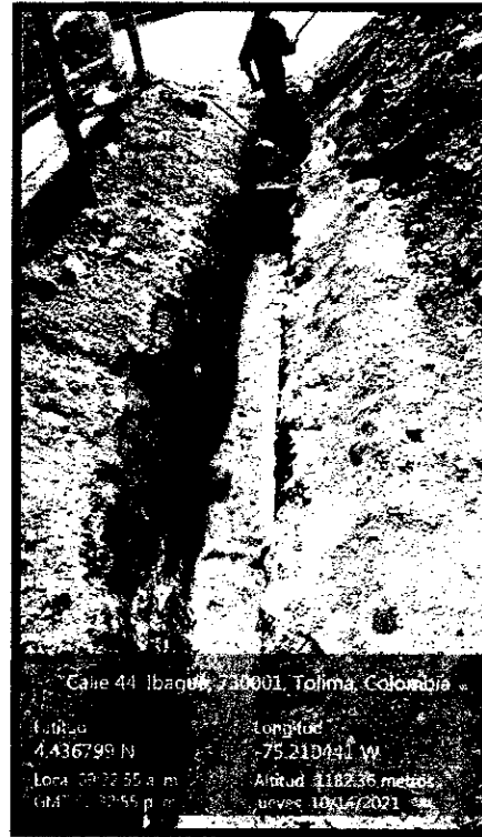
Ilustración 50. Excavación manual, Lecho de arena e instalación de tubería de 3" acueducto
