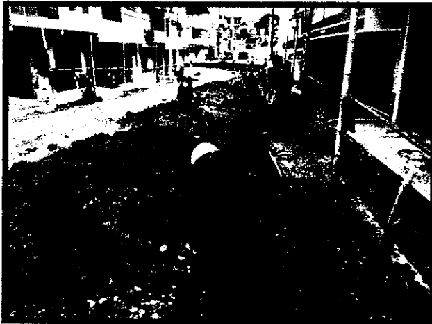
Ilustración 101. Excavación y suministra de recebo
