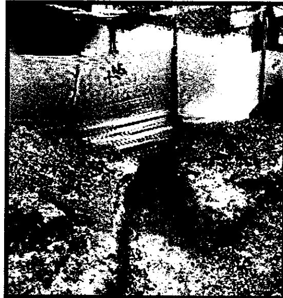
Ilustración 55. Compactación de recebo en zanja
