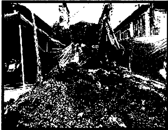
Ilustración 9. Cargue y retiro de sobrantes provenientes de excavaciones
