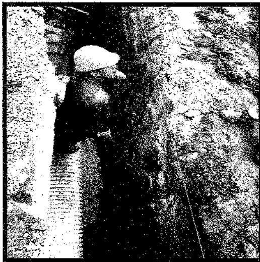
Ilustración 11. Instalación de lecho en grava
