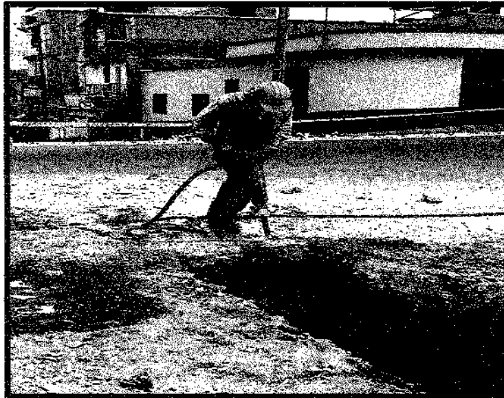
Ilustración 4. Rotura de pavimento rígido y flexible
