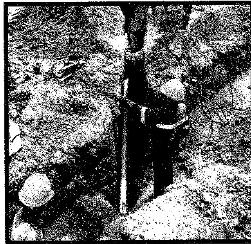
Ilustración 6. Instalación tubería 5"
