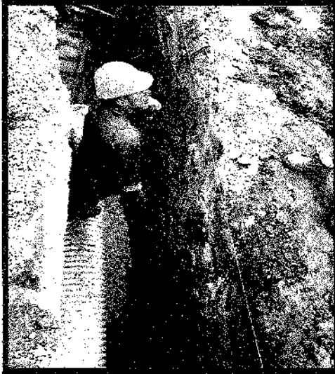
Ilustración 7. Instalación tubería 20"
