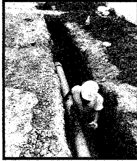
Ilustración 18. instalación de tubería 10"
