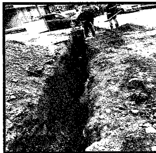
Ilustración 50. Suministro e instalación de lecho en grava
