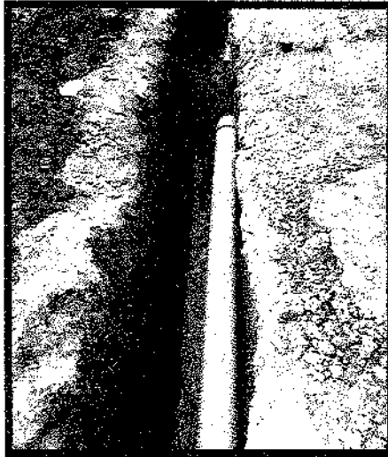
Ilustración 18. instalación de tubería 10"
