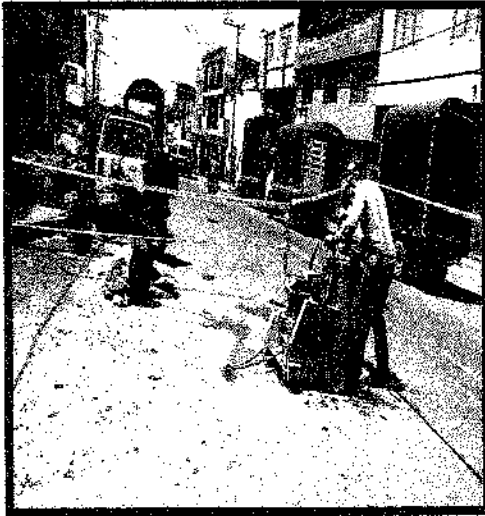
Ilustración 5. Corte de pavimento flexible y rígido
