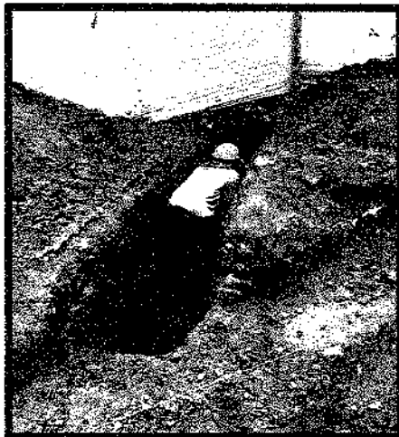
Ilustración 16. Excavación de domiciliarias
