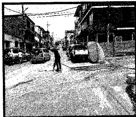
Ilustración 46. Rotura de pavimento flexible
