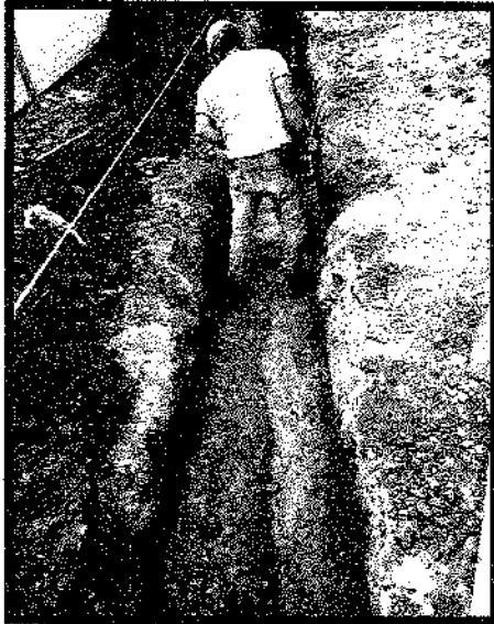
Ilustración 15. Compactación de recebo en zanja
