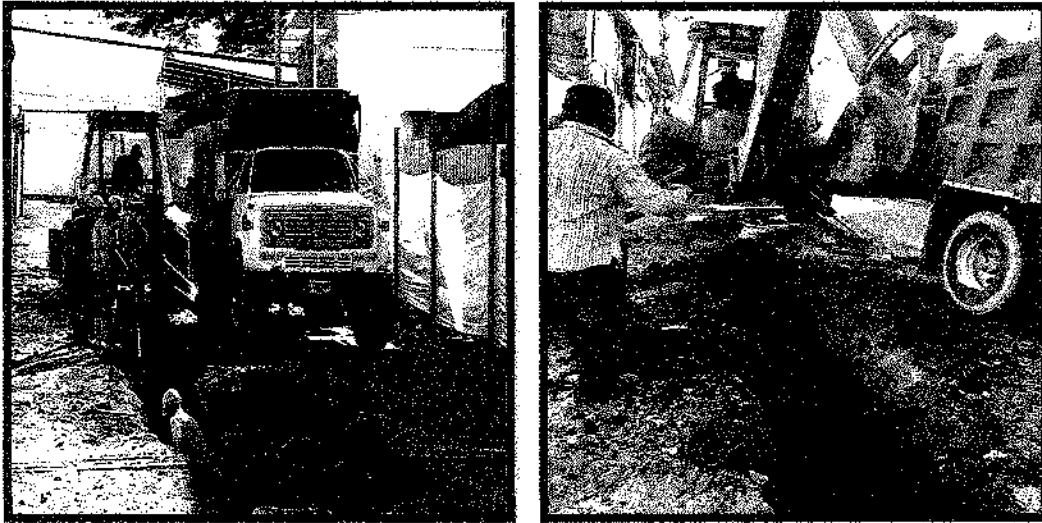
Ilustración 14. Cargue y retiro de sobrantes provenientes de excavaciones
