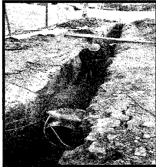
Ilustración 7. Instalación tubería 20"
