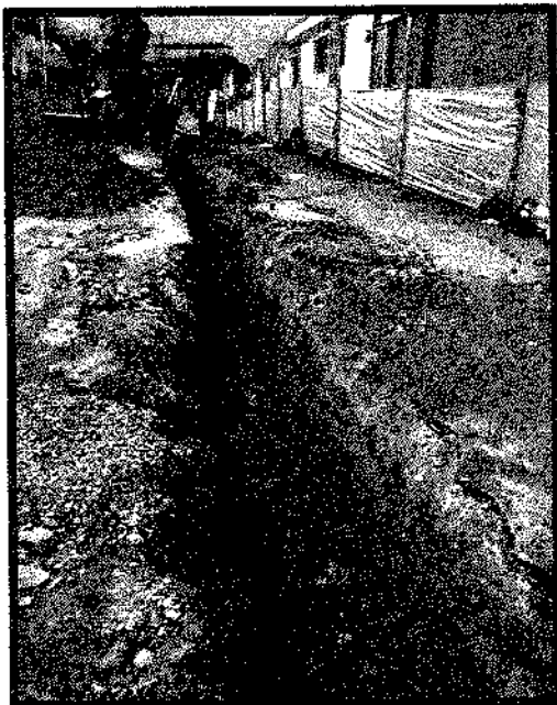
Ilustración 44. Suministro e instalación de recebo compactado
