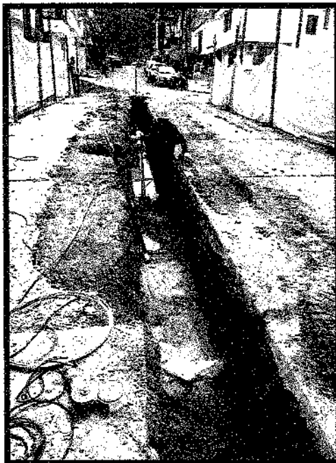
Ilustración 41. Instalación de recubrimiento en concreto de 3.000 psi
