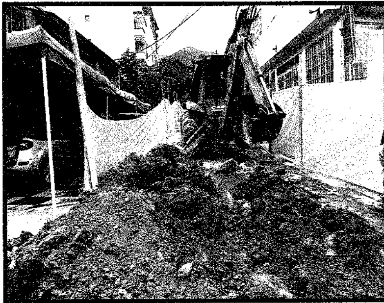
Ilustración 57. Cerramiento en guadua y polisombra
