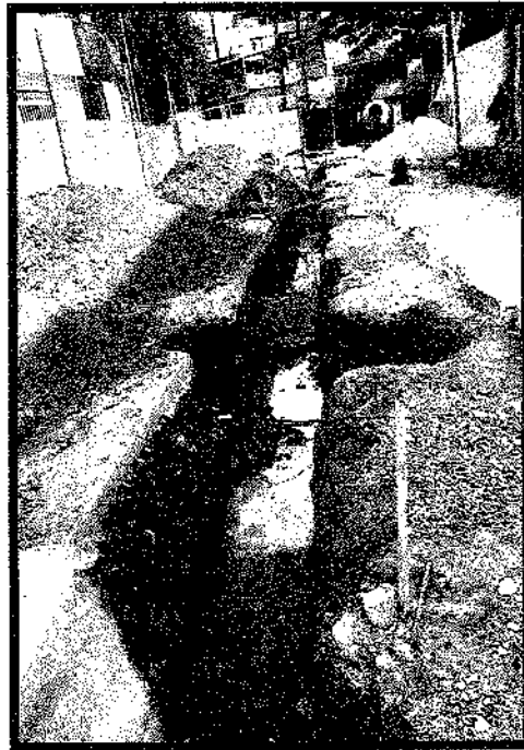
Ilustración 41. Instalación de recubrimiento en concreto de 3.000 psi
