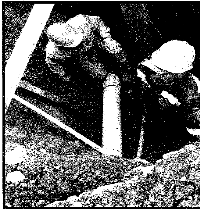
Ilustración 56. Instalación de tubería de 6" para domiciliarias
