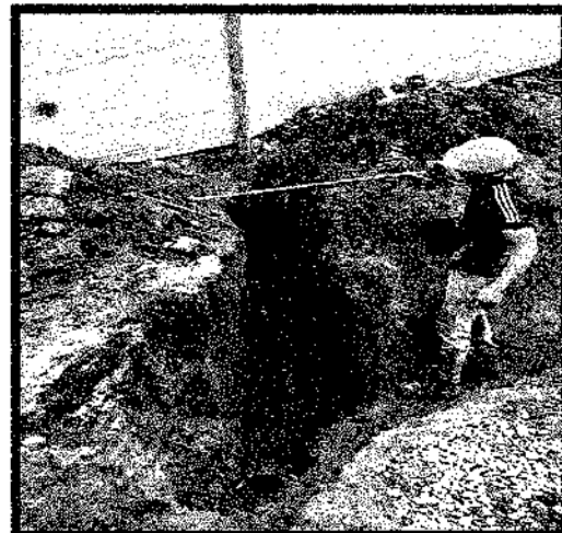
Ilustración 16. Excavación de domiciliarias
