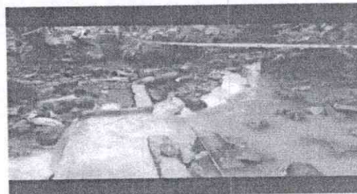
Foto No 12 y 13 Protección de la red en obra
