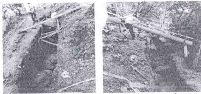
Foto No 10 y 11 Material rocoso encontrado en excavaciones
