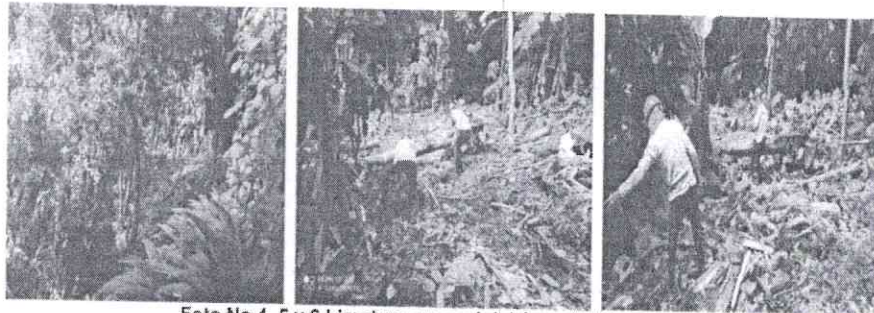
Foto No 4, 5 y 6 Limpieza general del área de intervención
