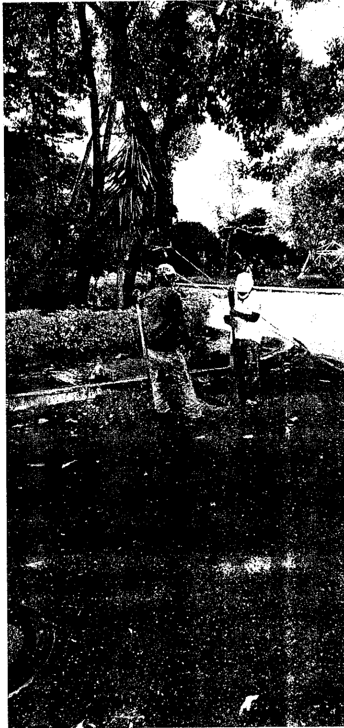
Trabajos de búsqueda de válvulas sobre la carrera 2c con calle 36
