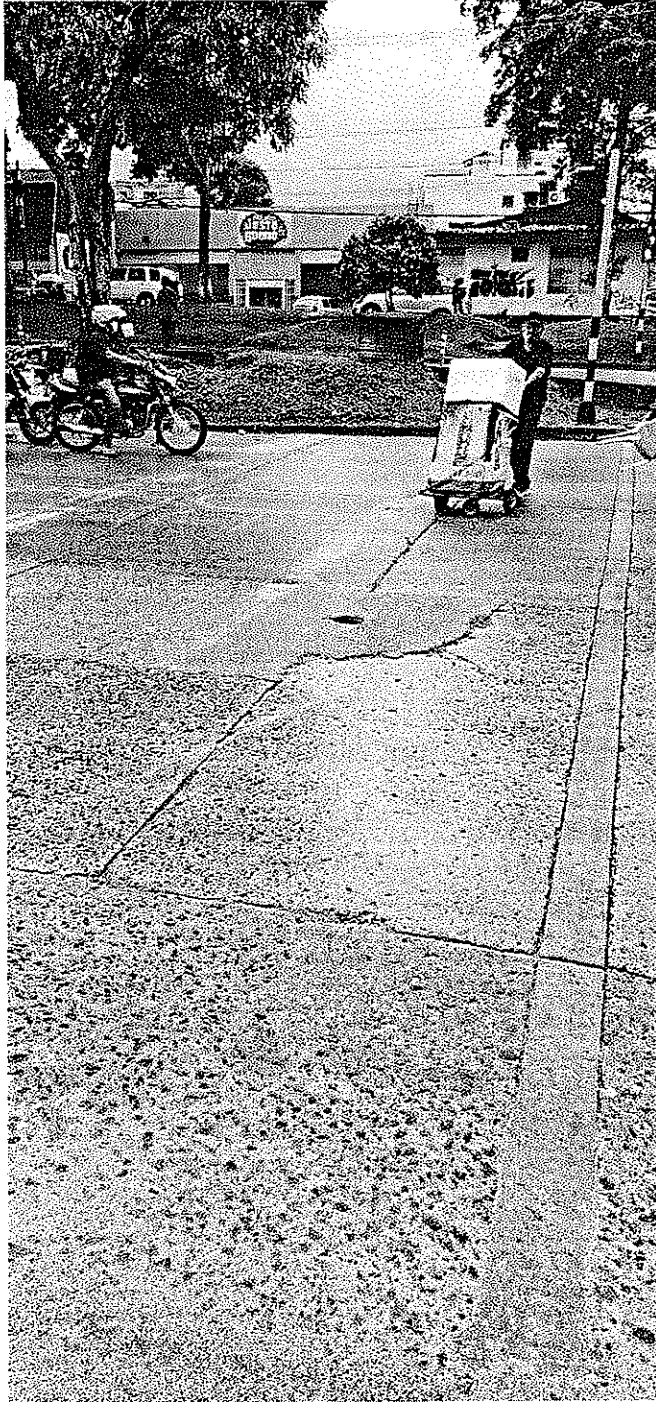
Calle 37 con Av. Ferrocarril
