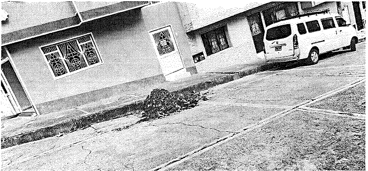
Escombros resultantes producto de la limpieza de la válvula varón
