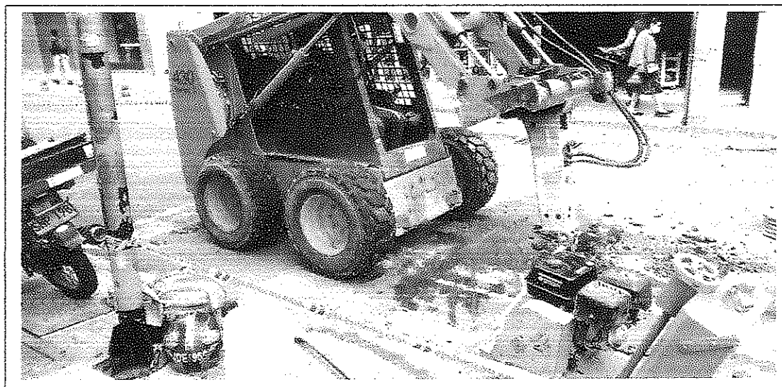
Calle 12 con carrera 1 centro
